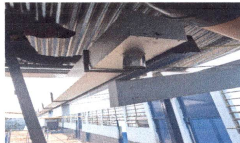
Foto 5: CANALES Y BAJADAS
