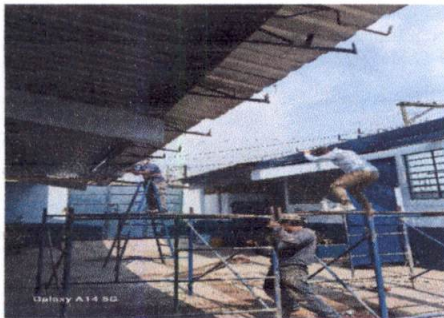
Foto 4: CANALES Y BAJADAS
