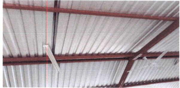
Foto 2 Estructuras de metal limpias y pintadas
