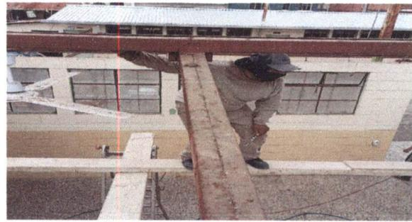
Foto 2 Limpieza de estructura metalica
