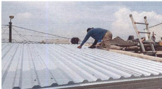
Foto 3 Colocación de laminas nuevas
