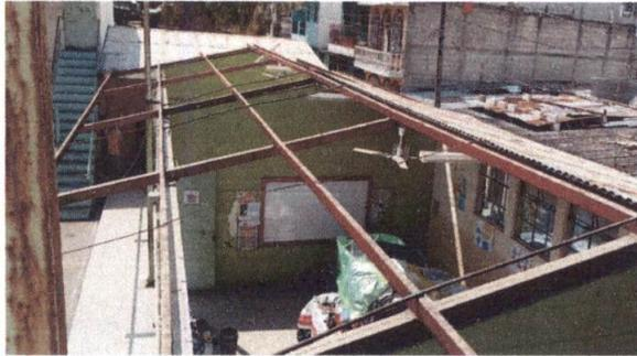
Foto 1 Desmantelado de techo
