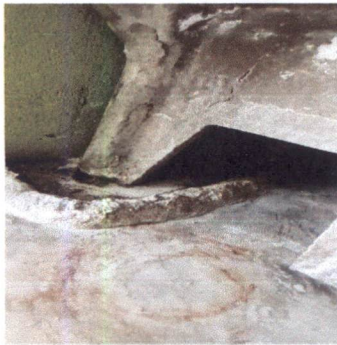
Foto 9: Cambio de todo el drenaje de la pila
