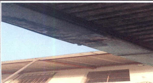
Foto 5: Canales para sustitución
