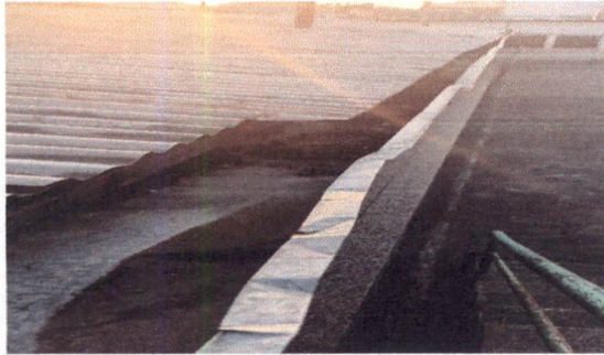
Foto 1: Vista de los canales que tendrán sustitución
