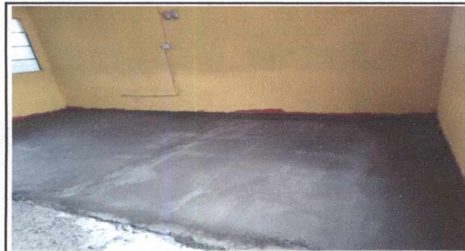
Foto 3: Aplicación de cernido para nivelar base de aulas para instalación de antideslizante.
