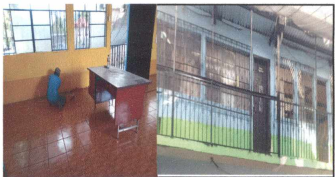
Foto 6: Pintura de muros exterior e interiores
