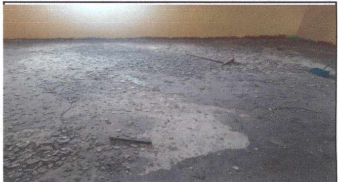
Foto 2: Demolición de piso alisado de concreto, de aula.
