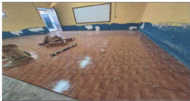
Foto 5: Instalación de piso antideslizante en aulas
