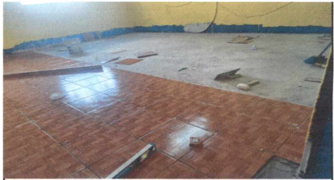
Foto 4: Instalación de piso antideslizante en aulas
