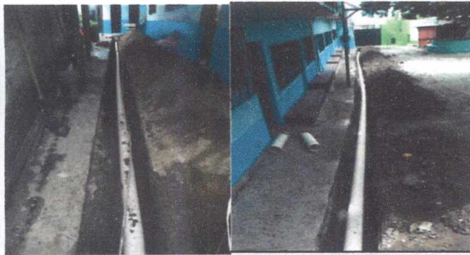
Foto 3: Sustitución de tubería PVC línea principal de aguas negras.
