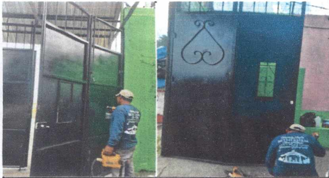
Foto 1: Mantenimiento a portón de metal
