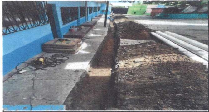
Foto 2: Sustitución de tubería PVC línea principal aguas negras
