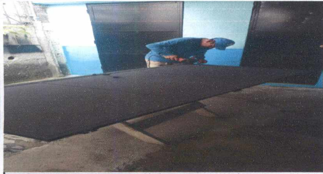
Foto 1: Mantenimiento de puerta de metal para nivelar piso
