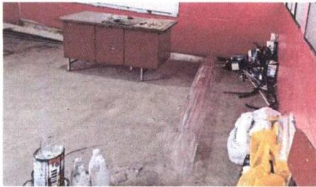
Foto 3: Aplicación de cernido para nivelar base de aula para instalación de antideslizante
