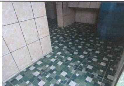
FOTO 5: INSTALACIÓN DE PISO CERÁMICO EN SERVICIOS SANITARIOS. EL ÁREA DE LOS AMBIENTES NO COINCIDE CON LO INDICADO EN EL PRA-FOR-122.
