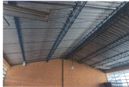
FOTO 2: SUSTITUCIÓN DE LÁMINA TROQUELADA ALUZINC CALIBRE 26
