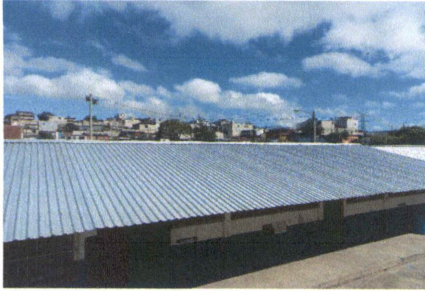
FOTO 1: SUSTITUCIÓN DE LÁMINA TROQUELADA ALUZINC CALIBRE 26
