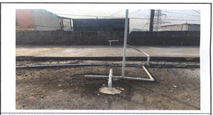
INSTALACION DE NUEVA TUBERIA PARA ABASTECER TINACOS DE AGUA POTABLE
