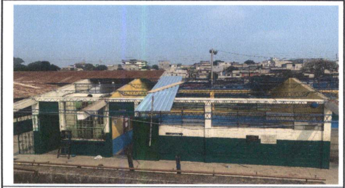
FOTO 1: CUBIERTA DE LAMINA
