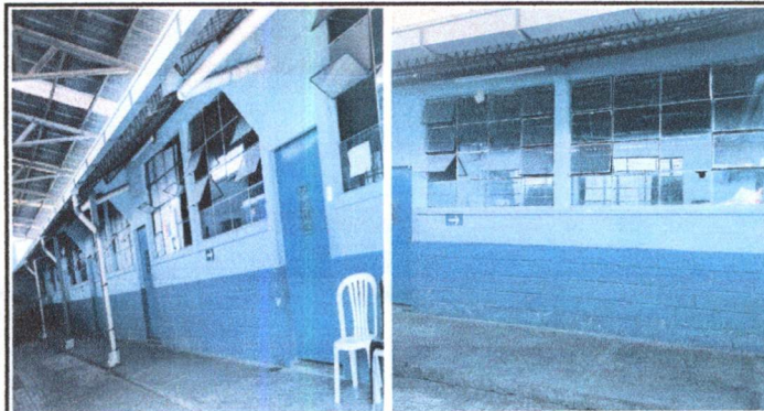
Cambio de ventanas de PVC e instalaciones de balcones.
