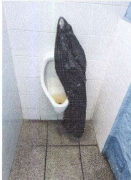
Foto 13: 10. SERVICIOS SANITARIOS Y SUS ACCESORIOS: Desmontaje y reparación de mingitorio en sanitario para varones
