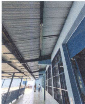
Foto 15: 17 REPARACIÓN DEL SISTEMA ELECTRICO Revisión y reparación del circuito de luces del pasillo de las aulas del patio exterior
