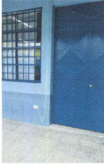
Foto 19: Reubicar y sustituir cable de alimentación de cámaras patio frontal módulo 1
