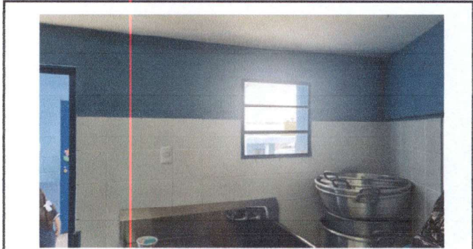
Foto 2: 5 VENTANAS: Desmontaje de ventana de la cocina, ampliación de vano de ventana, instalación de ventana corrediza de metal con medidas 1.30*0.70mts
