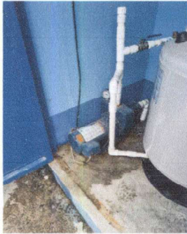
Foto 25: Reparación de fuga de conexión de bomba de agua
