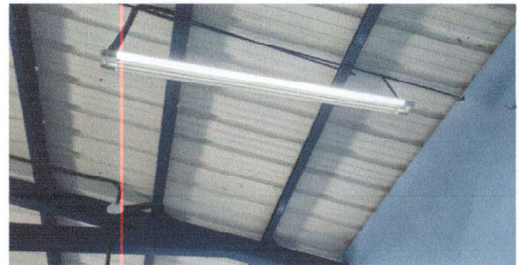
Foto 24: Cambio de lámpara en aula No. 1 módulo 1
