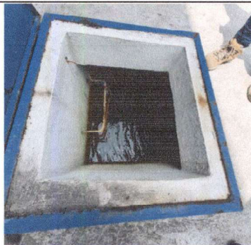
Foto 17: 18. REPARACIÓN Y MANTENIMIENTO DE CISTERNA/DEPOSITO DE AGUA : Limpieza y mantenimiento de cisterna de concreto, vaciado de bomba y limpieza
