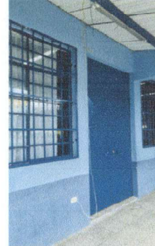
Foto 20: Cambio de cable alimentación de cámaras patio frontal módulo 1
