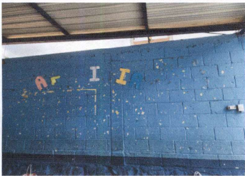
Foto 9: 9.PINTURA DE MUROS EXTERIORES E INTERIORES: Aplicación de pintura en muros exteriores e interiores en dos tonalidades
