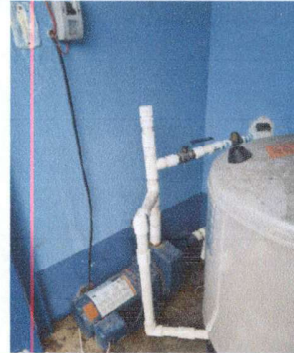
Foto 26: Reparación de fuga de conexión de bomba de agua
