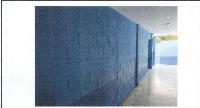
Foto 31: Apertura de ventanas en el salón No. 4 módulo 2
