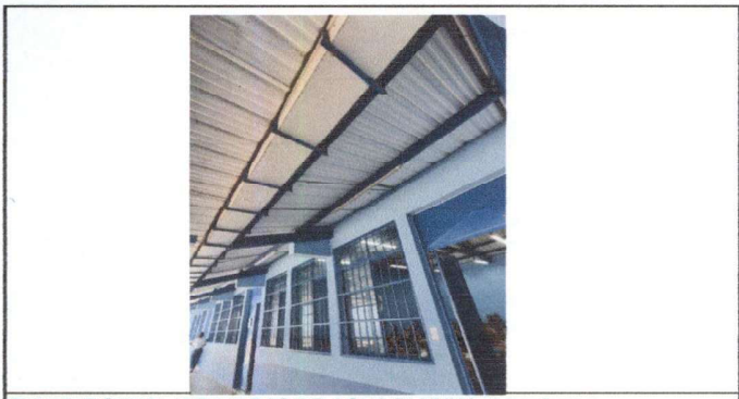
Foto 5: 7 CANAL Y BAJADAS DE AGUA PLUVIAL: Limpieza y mantenimiento de canales 2do nivel
