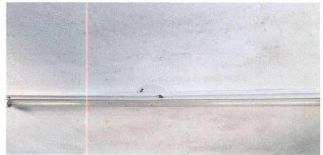
Foto 16: 17 REPARACIÓN DEL SISTEMA ELECTRICO Revisión y reparación del sistema de luz en la cocina
