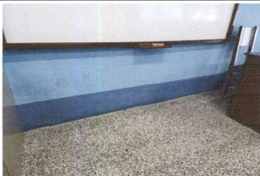
Foto 11: 9.PINTURA DE MUROS EXTERIORES E INTERIORES: Aplicación de pintura en muros exteriores e interiores en dos tonalidades
