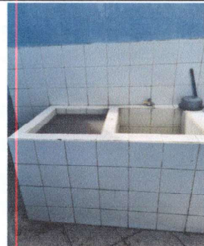
Foto 28: Reparación de drenaje tapado en la pila, romper, revisar y sustituir la tubería
