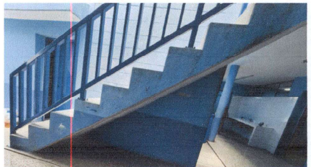
Foto 12: 9.PINTURA DE MUROS EXTERIORES E INTERIORES: Aplicación de pintura en muros exteriores e interiores en dos tonalidades
