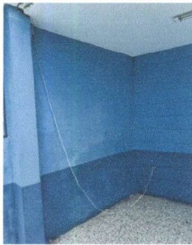
Foto 21: Colocación de canales en cable de cámara 3er patio módulo 2
