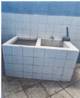
Foto 27: Reparación de drenaje tapado en la pila, romper revisar y sustituir la tubería
