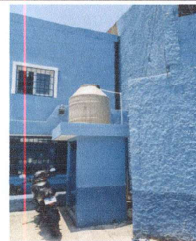
Foto 18: 18. REPARACIÓN Y MANTENIMIENTO DE CISTERNA/DEPOSITO DE AGUA : Desmontaje y traslado e instalación de deposito existente, compra e instalación de nuevo deposito de agua de 2,500 lts
