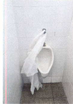
Foto 14: 10. SERVICIOS SANITARIOS Y SUS ACCESORIOS: Desmontaje y reparación de mingitorio en sanitario para varones
