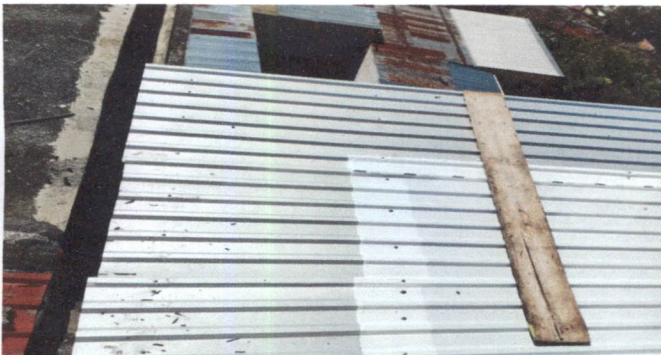
Foto 3: Instalación de tubería para agua pluvial, levantando con lámina para la canaleta y de la canaleta conectado la caída de agua hacia drenaje dentro del establecimiento
