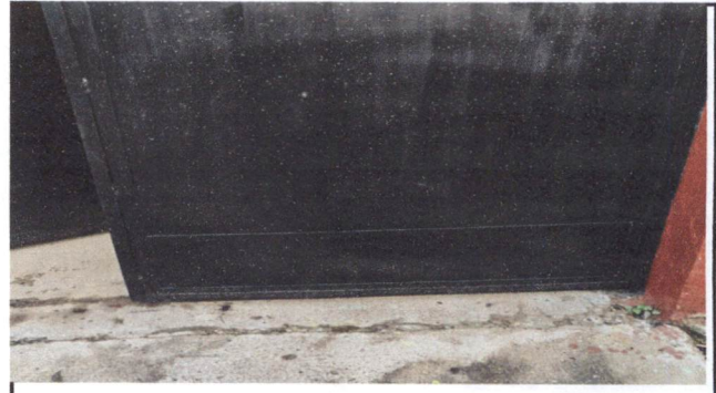
Foto 2: Mantenimiento de estructura de porton (lijado, cepillado, aplicación de pintura)
