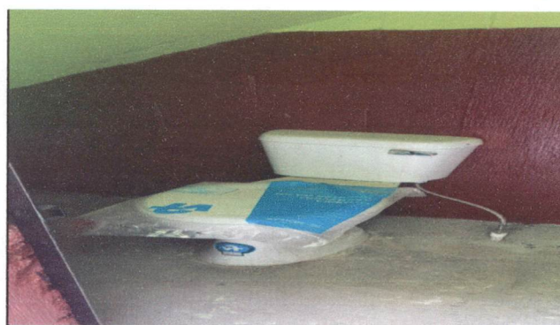
Foto 4: Sustitución de sanitario en el área de preprimaria para niños y niñas
