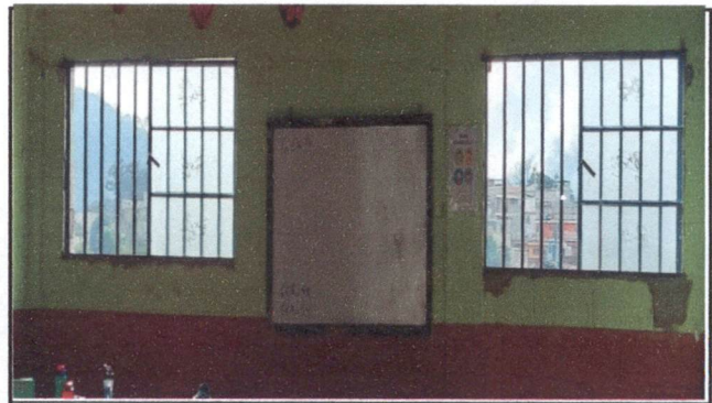
Foto 6: Instalación y remodelación de 10 ventanas tipo balcones corrediza e instalacion de vidrios.
