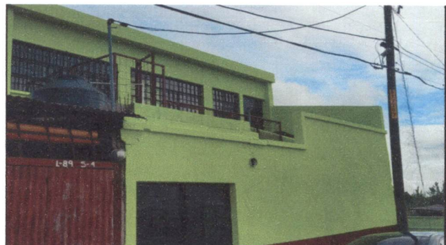
Foto 4: Pintura interior de 5 aulas y 2 sanitarios niñas y niños, exterior del establecimiento.
