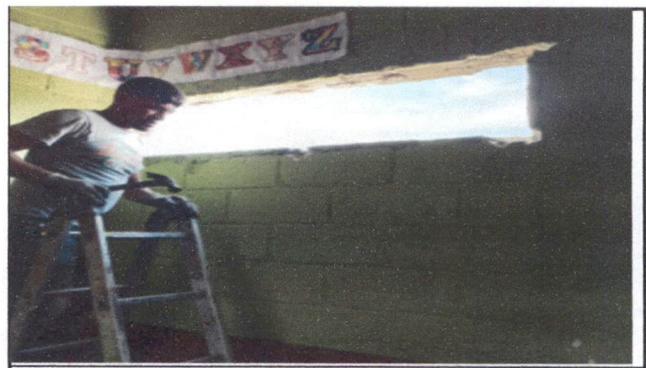
Foto 4: Desmontaje y ampliación de ventanas (10 ventanas)
