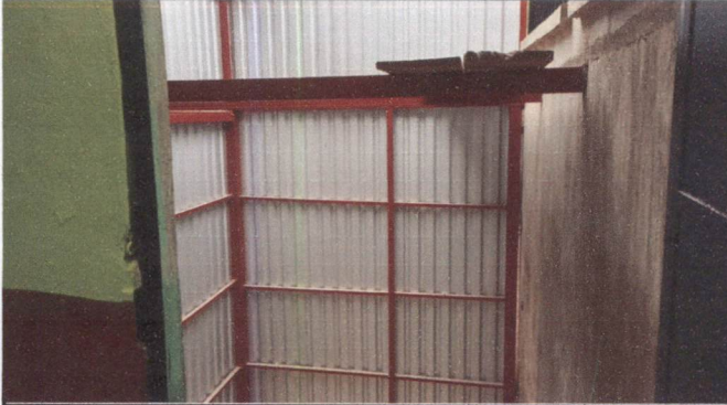
Foto 1: Sustitución de lámina, por lámina troquelada aluzinc calibre 26 ( para 1 salon)
