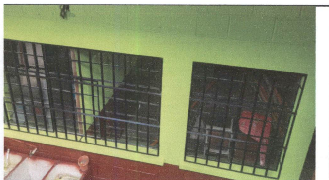
Foto1: Mantenimiento de estructura de ventanas (lijado, cepillado, aplicación de pintura. ( 4 aulas)
