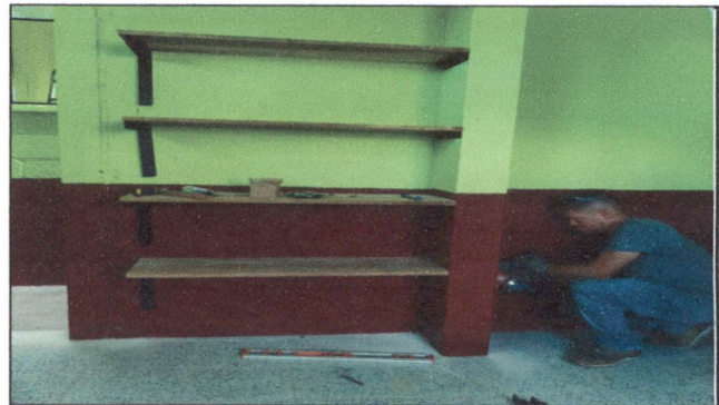
Foto 2: Instalacion de entrepiso de madera tipo estanteria para biblioteca
