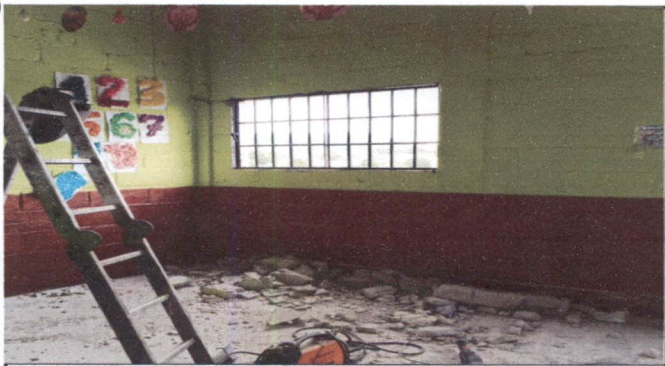
Foto 5: instalacion de ventana tipo balconcorredizo (10 ventanas)
