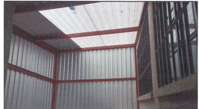
Foto 2: Sustitución de lámina, por lámina troquelada aluzinc calibre 26 y levantamiento de 2 metros para evitar caída de agua ( para 1 salon)
