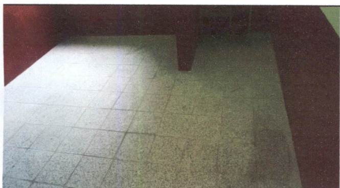
Foto 3: Piso de granito para un aula.
