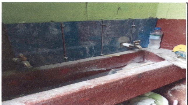
Foto 6: Sustitución de lavamanos y colocación de azulejos.
