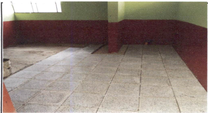
Foto 3: Piso de granito para un aula.
