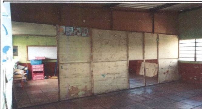
Foto 3: Sustitución de estructura de madera por madera ( para 4 salones)
