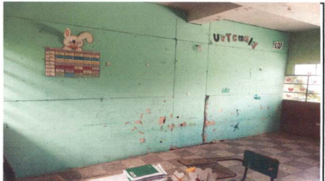
Foto 4: Sustitución de estructura de metal por metal ( para 4 salones)
