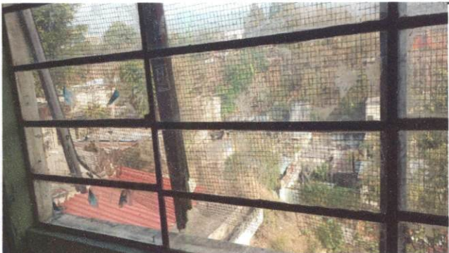
Foto1: Mantenimiento de estructura de ventanas (lijado, cepillado, aplicación de pintura. ( 4 aulas)
