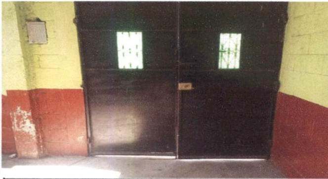
Foto 1 Mantenimiento de estructura de porton (lijado, cepillado, aplicación de pintura).
