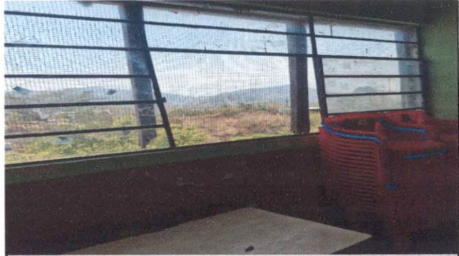
Foto 2: Sustitución de balcones de metal dee 1.20 X 1.40 mts. (Para 4 salones)
