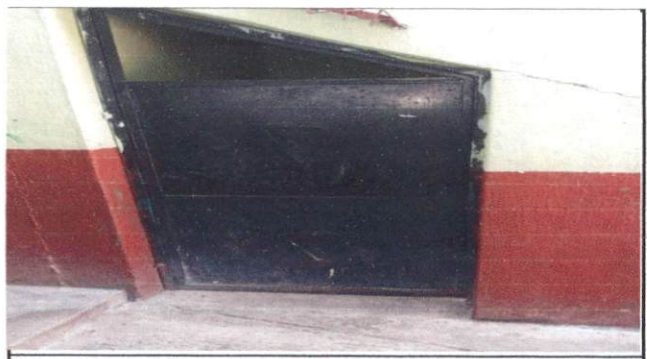
Foto 6: Mantenimiento de estructura de puertas (lijado, cepillado, aplicación de pintura. ( 3 puertas de aulas y 2 baños de niñas y niños)
