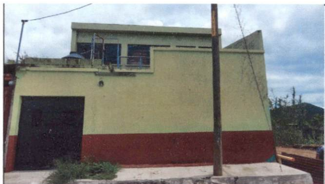
Foto 4: Pintura interior de 5 aulas y 2 sanitarios niñas y niños, exterior del establecimiento.
