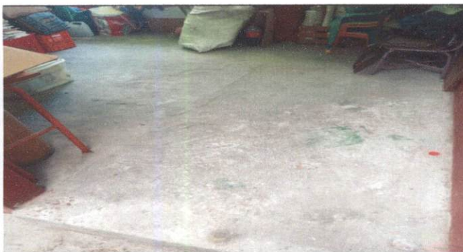
Foto 3: Piso de granito para un aula.
