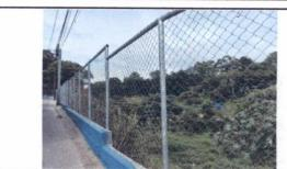
FOTO 6: SUSTITUCIÓN DE MALLA Y TUBO HG EN MURO PERIMETRAL
