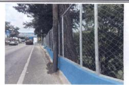
FOTO 2: SUSTITUCIÓN DE MALLA Y TUBO HG Y REPARACIÓN DE MURO PERIMETRAL DAÑADO
