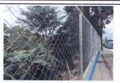
FOTO 4: SUSTITUCIÓN DE MALLA Y TUBO HG EN MURO PERIMETRAL
