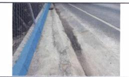
FOTO 5: REPARACIÓN DE CUNETA DE CONCRETO
