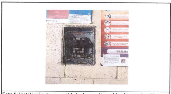
Foto 5: Instalación de acometida incluye quitar cableado actual, cablear nuevamente y colocación de nuevo tablero eléctrico y flipones
