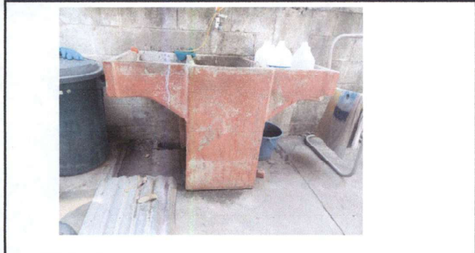
Foto 13: Cambio de pila por otra de concreto, incluye nivelar, pegar, sellar, caja, cambiar chorro y tubería hacia cisterna.
