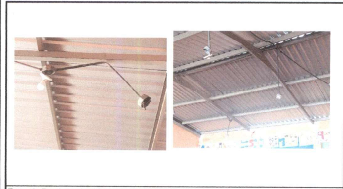
Foto 1: Desinstalación e instalación de iluminación, incluye tubería, cableado, plafonera y bombilla
