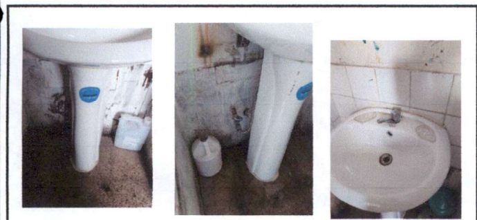
Foto 11: Reparación de lavamanos incluye, llaves, reparación de fugas, cambiar sifones, contrallaves, mangueras y limpieza
