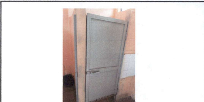
Foto 10: Reparación de puerta de baño.
