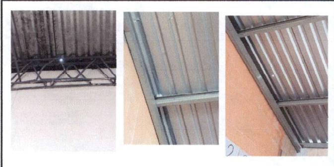
Foto 8: Reparación de goteras con silicón y/o tapagoteras en las aulas del establecimiento.
