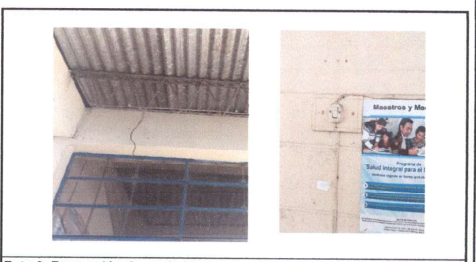
Foto 6: Reparación de un timbre y pulsador
