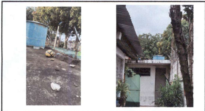
Foto 15: Suministro e instalación de tinaco de 1100 litros.
