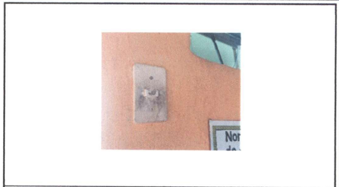
Foto 2: Desinstalación e instalación de apagadores, incluye cableado
