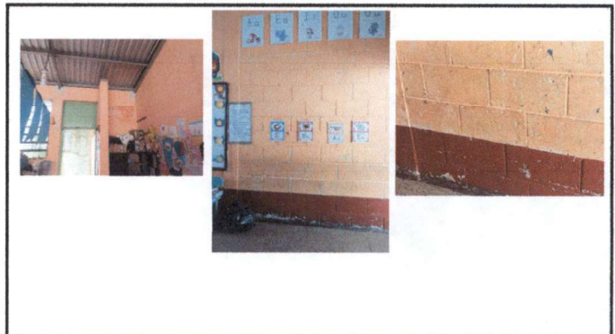
Foto 16: Aplicación de pintura en muros interiores, en 2 tonalidades uno más oscuro para zócalo y uno más claro para el resto del muro, se cobra este precio ya que los muros son cizados.
