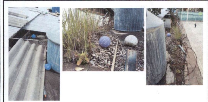
Foto 7: Limpieza de terrazas, limpieza de bajadas de agua, extracción de ripio, colocación de bordillos para terrazas con media caña, impermeabilización de las mismas, retirar dos cisternas, limpieza de los
