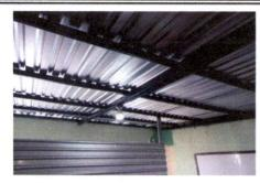
FOTO 1: SUSTITUCIÓN DE CUBIERTA DE LÁMINA, MANTENIMIENTO DE ESTRUCTURA DE METAL E INSTALACIÓN DE FOCOS
