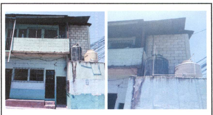
Foto 4: Bajada de agua pluvial, sustitución de accesorios para tanques y cambio de flotes
