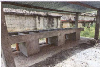
FOTO 6: SUSTITUCIÓN DE PILAS POR PILA DE 6 LAVADEROS DE CONCRETO
