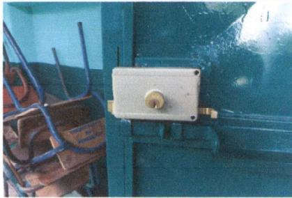
FOTO 3: SUSTITUCIÓN DE CHAPA EN PUERTA
