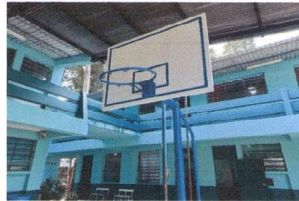
FOTO 2: MANTENIMIENTO A ESTRUCTURA DE METAL DE CANASTAS DE BASQUETBOL, LIJADO Y APLICACIÓN DE ANTICORROSIVO Y PINTURA.
