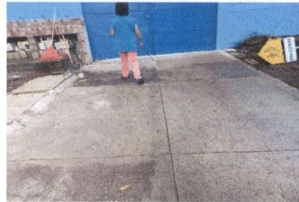
FOTO 4: REPARACIÓN DE TORTA DE CONCRETO EN ÁREA DE INGRESO, DEBIDO A DAÑOS PROVOCADOS POR LA RAÍZ DEL ÁRBOL
