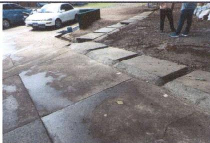
FOTO 5: REPARACIÓN DE PLANCHAS DE CONCRETO QUE CUBREN CUNETETA EN ÁREA DE INGRESO
