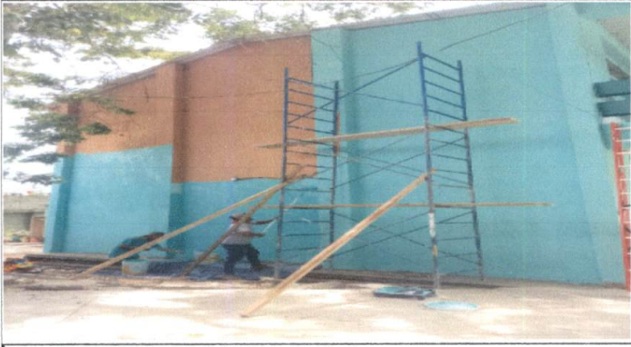
Foto 15: Pintura en áreas del primer nivel.
