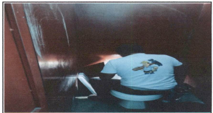
Foto 12: Sustitución de tapadera y redondel de sanitarios.
