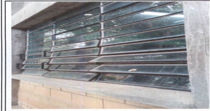
Foto 1: Sustitución de vidrios e instalación de malla galvanizada, fabricación e instalación de balcón de metal.
