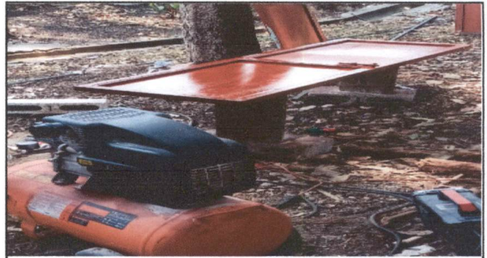
Foto 10: Mantenimiento de puertas de sanitarios .
