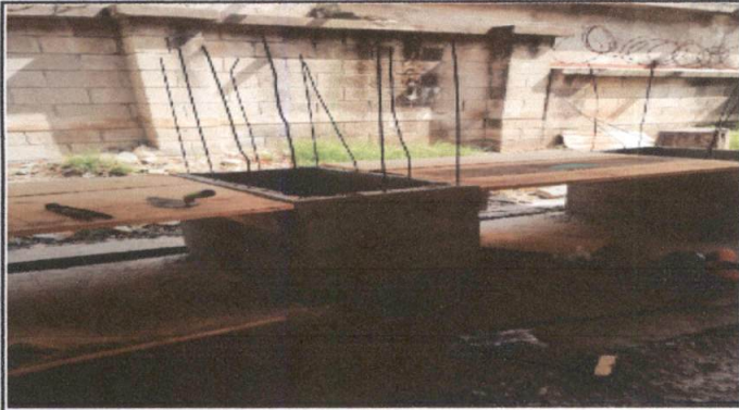
Foto 7: sustitución de pilas.
