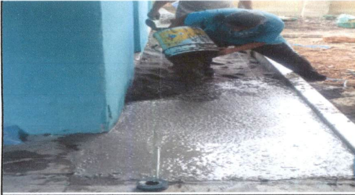
Foto 13: Reparación de banqueta de concreto
