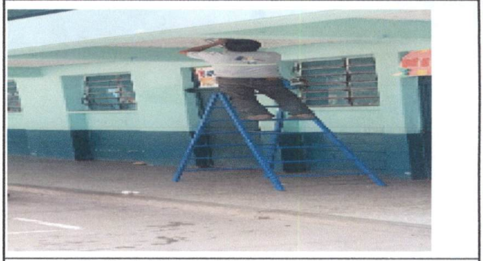
Foto 4: Sustitución de lámparas dañadas.
