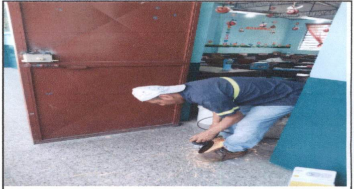
Foto 2: Instalación de 4 chapas en el 2do nivel.
