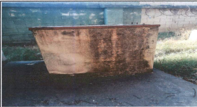
Foto 9: Reparación de sistema de concreto. (Pendiente de reparación)
