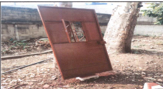
Foto 11: Mantenimiento de puertas de sanitarios .
