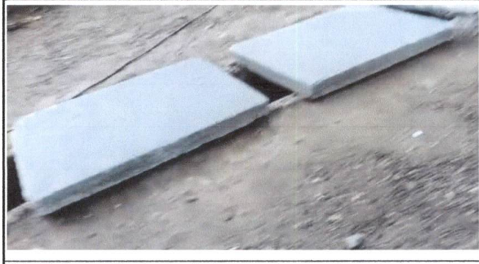
Foto 16: Reparación de plancha de concreto que cubre parte de cuneta.
