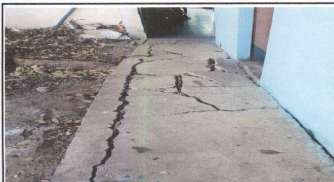
Foto 13: Reparación de banqueta de concreto
