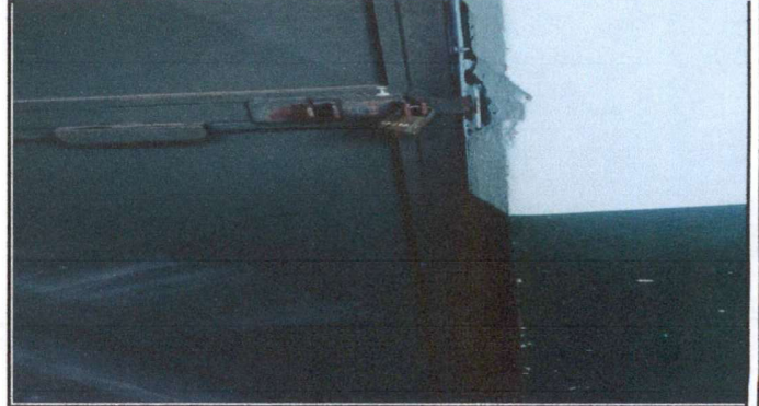
Foto 2: Instalación de 4 chapas en el 2do nivel.
