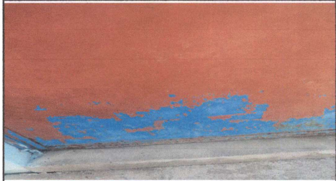
Foto 10: Mantenimiento de puertas de sanitarios .
