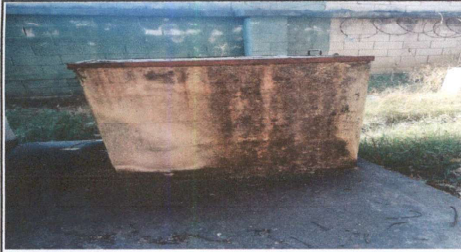
Foto 9: Reparación de sistema de concreto.
