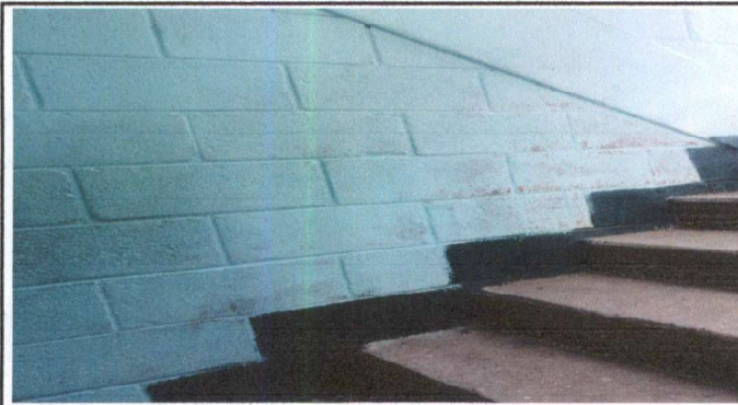
Foto 3: Pintura en áreas del primer nivel cocinas, bodegas, aulas, sanitarios y módulo 2 de gradas.
