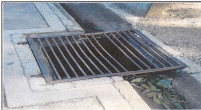
Foto 14: Fabricación e instalación de rejillas en cunetas y reposadera
