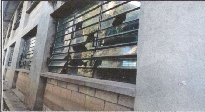
Foto 1: Sustitución de vidrios e instalación de malla galvanizada, fabricación e instalación de balcón de metal.
