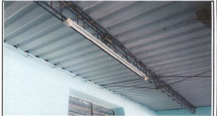
Foto 4: Sustitución de lámparas dañadas.
