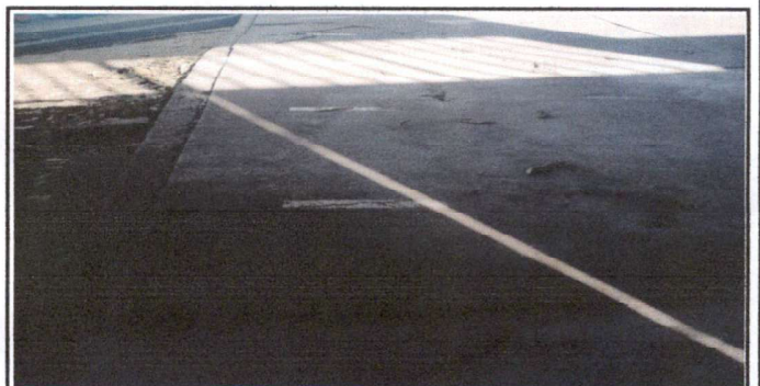
Foto 6: Reparación de placa de concreto por daño de la raíz de árbol.
