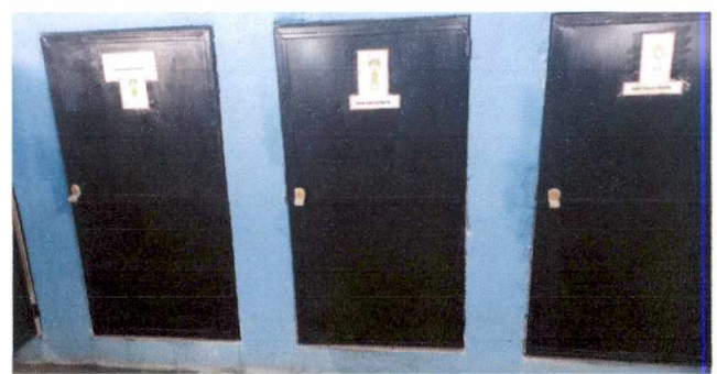
Foto 6: INSTALACION DE CHAPAS EN BAÑOS DE NIÑOS
