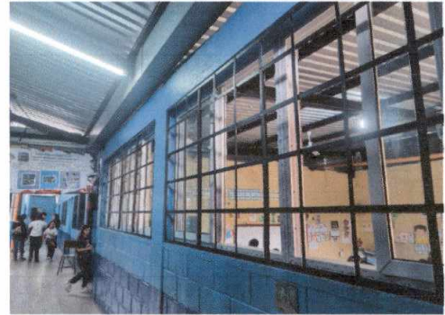
Foto 4: INSTALACIÓN DE VENTANAS DE PVC
