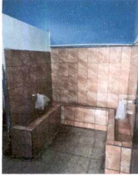
Foto 1: INSTALACION DE AZULEJO EN MINGITORIOS
