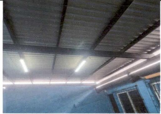
Foto 2: REPARACION DE CANDELAS DEL PATIO
