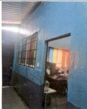
Foto 5: INSTALACIÓN DE BALCONES
