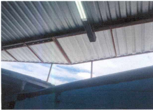
Foto 3: AMPLIACION DE TECHO
