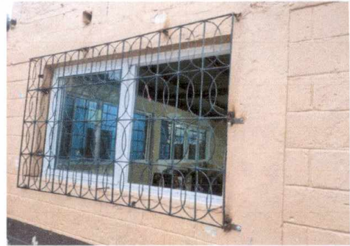
Foto 4: REPARACIÓN DE BALCONES
