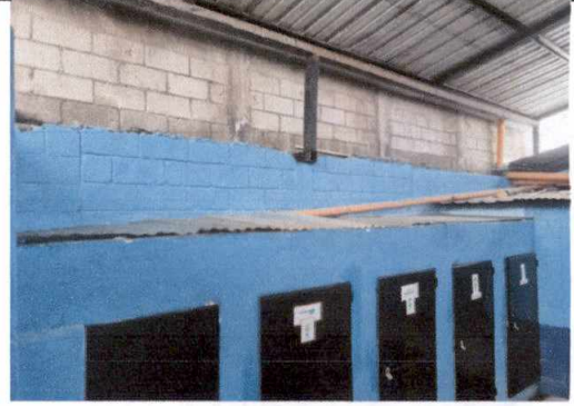
Foto 2: INSTALACIÓN DE TECHO EN LOS BAÑOS DE NIÑOS
