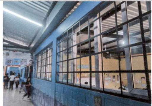
Foto 6: PINTURA DE BALCONES
