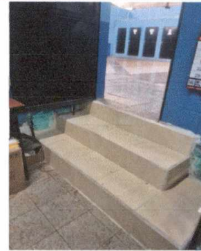
Foto 2: CAMBIO DE PISO EN LAS GRADAS DE DIRECCIÓN
