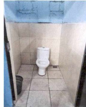
Foto 4: INSTALACIÓN DE PISO CERÁMICO EN BAÑOS DE PREPRIMARIA
