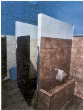
Foto 3: REPARACIÓN DE PARED EN BAÑOS DE PRIMARIA
