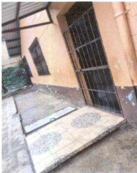
Foto 5: RAMPA EN LA ENTRADA PRINCIPAL
