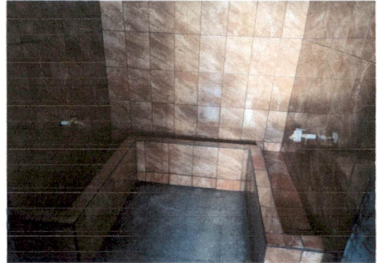
Foto 8 Sustitución de azulejo en Mingitorio
