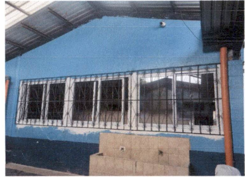
Foto 2: Sustitución de ventaneria fija
