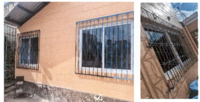
Foto 12. reparación y pintura de balcones
