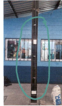
Foto 4: Sustitución de tomacorrientes
