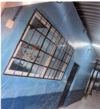
Foto 11 . Instalación de balcones
