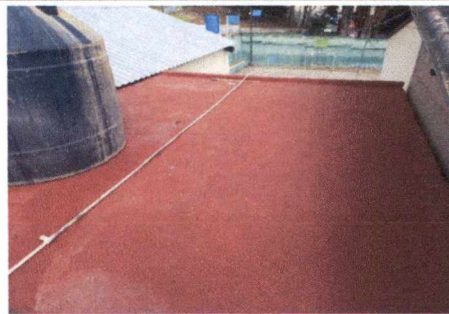
FOTO 10: IMPERMEABILIZACIÓN DE LOSA EN DIRECCIÓN
