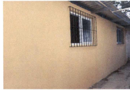
FOTO 4: INSTALACIÓN DE BALCONES EN SALÓN CULTURAL
