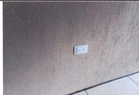
FOTO 6: INSTALACIÓN DE TOMACORRIENTES DOBLES EN SALÓN CULTURAL
