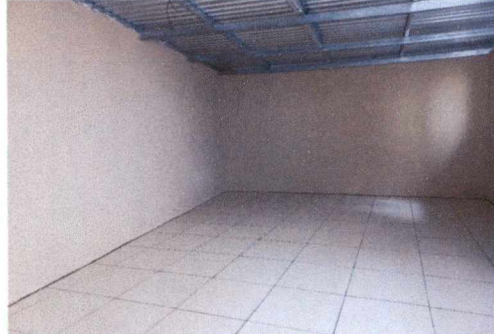
FOTO 2: INSTALACIÓN DE PISO CERÁMICO EN SALÓN CULTURAL
