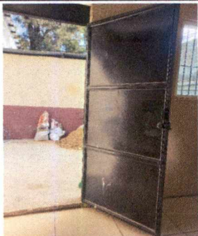
FOTO 7: MANTENIMIENTO A PUERTA DE METAL EN SALÓN CULTURAL
