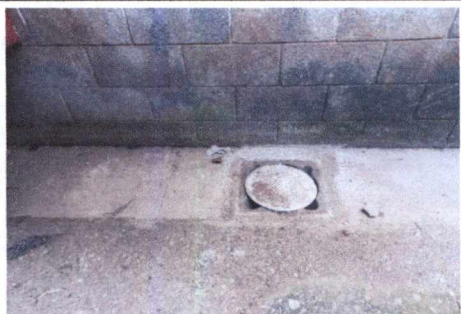
FOTO 9: INSTALACIÓN DE REPOSADERAS EN ÁREA DE PATIO
