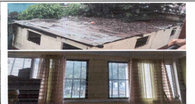
Foto 5: Sustitucion de 5 ventanas
