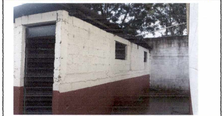
Foto 8: Pintura en muros exteriores e interiores
