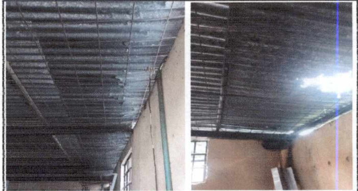
Foto 2: Cambio de estructura de techo, desmontar electromalla
