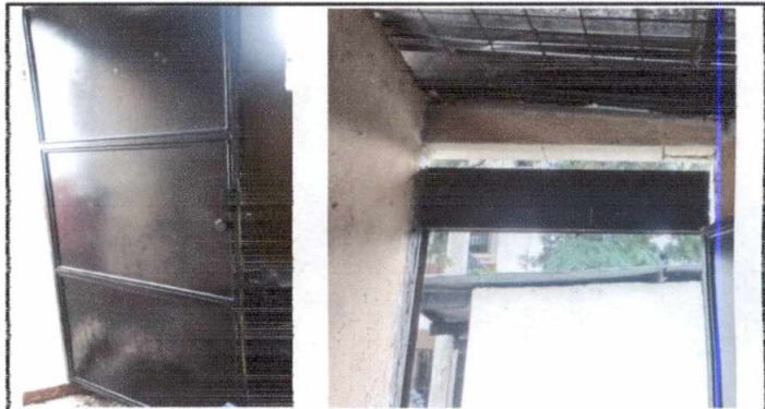
Foto 4: Remozamiento de puerta de metal
