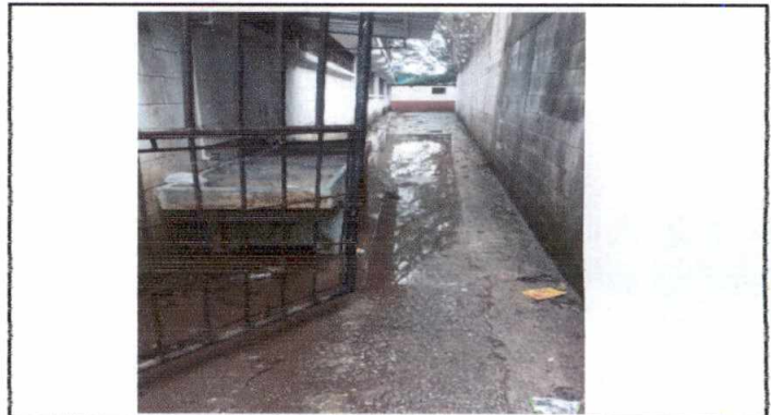
Foto 10: Instalación de 2 reposaderas en area de pilas
