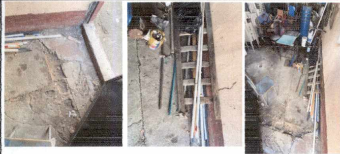
Foto 7: Instalación de Piso Ceramico
