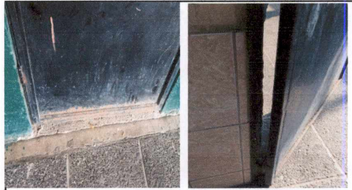
Foto 4: Remosamiento de puertas de metal
