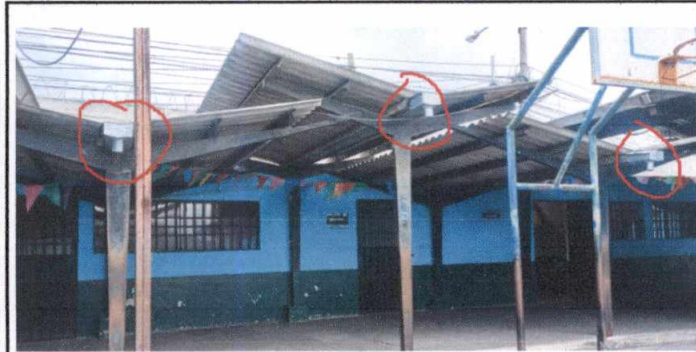
Foto 5: Cambio de canales en pasillo principal
