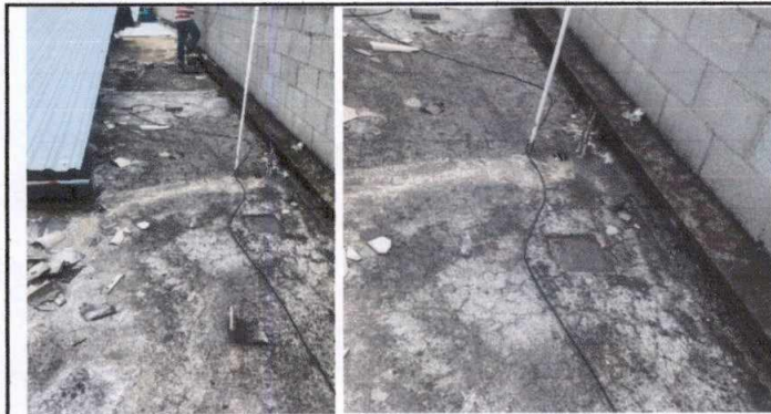
Foto 3: Impermeabilización de losa, resanado, nivelación
