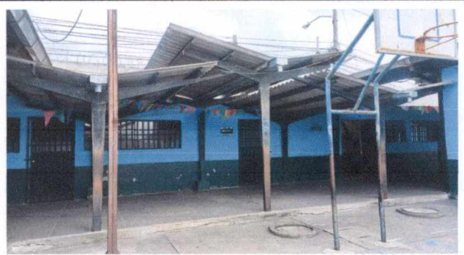
Foto 2: Mantenimiento de estructura de metal pasillo principal
