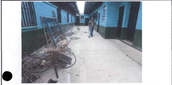
FOTO 7: TORTA DE CONCRETO EN PATIO
