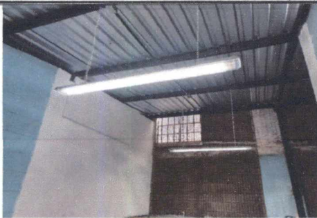
FOTO 5: INSTALACIÓN DE LÁMPARAS LED
