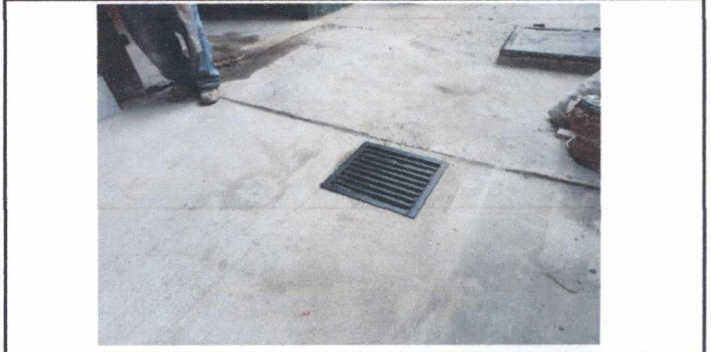
FOTO 8: (TRABAJO EXTRA) INSTALACIÓN DE DRENAJE DE AGUA PLUVIAL INCLUYENDO REPOSADERAS CON REJILLAS DE METAL
