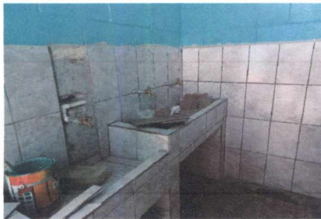
FOTO 3: SUSTITUCIÓN DE PILA POR LAVAMANOS DE CONCRETO
