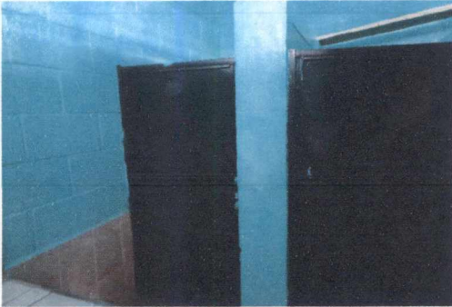
FOTO 1: MANTENIMIENTO DE PUERTAS DE METAL EN SERVICIOS SANITARIOS
