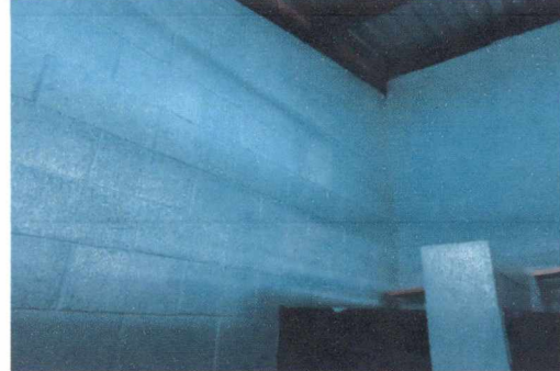
FOTO 2: APLICACIÓN DE PINTURA EN MUROS
