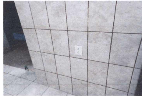
FOTO 4: INSTALACIÓN DE AZULEJO Y TOMACORRIENTES
