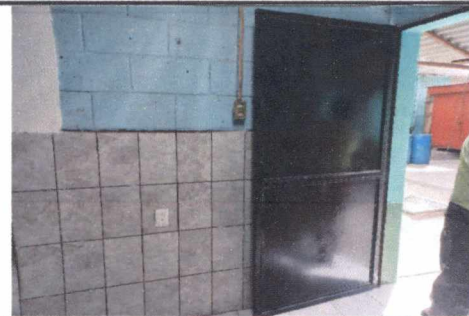
FOTO 6: MANTENIMIENTO DE PUERTA DE METAL DE COCINA
