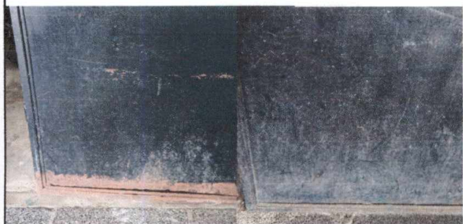
Foto 3: Remosamiento de puertas de metal
