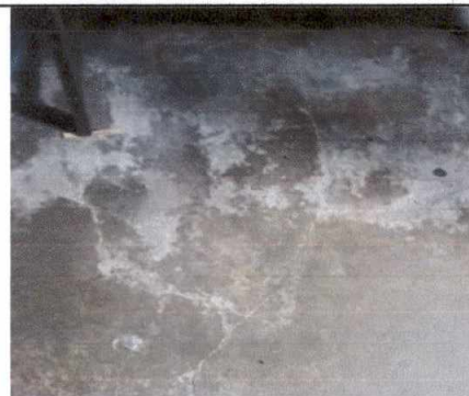
Foto 4: Instalación de piso Ceramico en cocina
