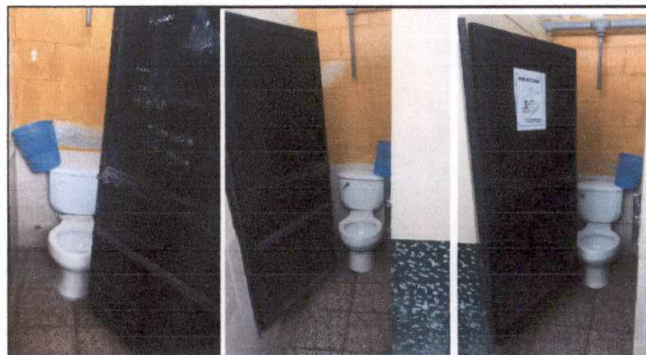
Foto 6: Remosamiento de puertas sanitarios
