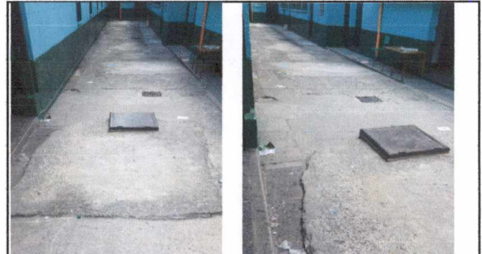
Foto 12: Fundición de losa de patio
