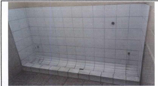
Foto 9: Sustitución de migitorio de concreto
