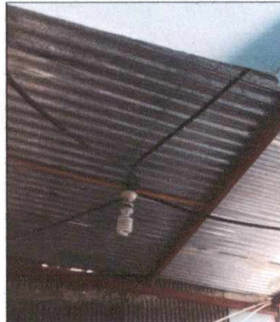
Foto 2: Sustitución de estructura de techo
