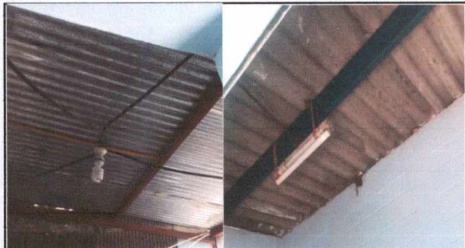
Foto1: Cambio de lamina en techo de cocina
