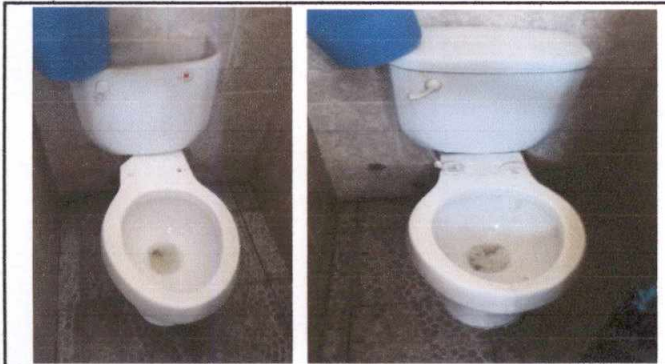
Foto 7: Sustitución de inodoros
