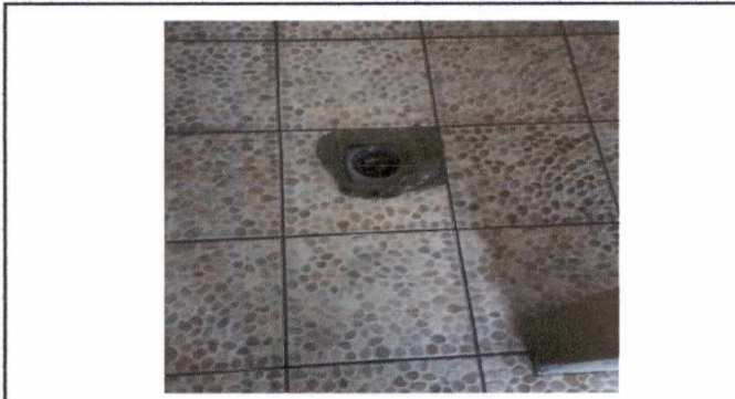
Foto 11: Mantenimiento a reposaderas de baño niños / romper drenaje
