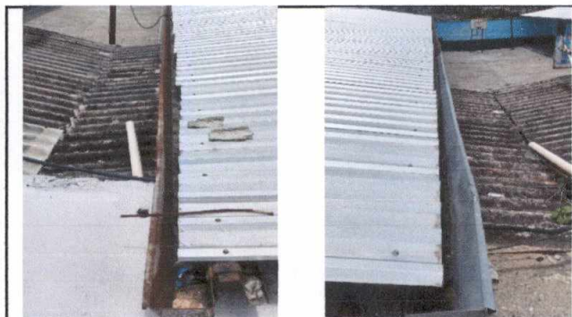
Foto 5: Cambio de canales
