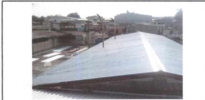
foto 3, sustitucion de lamina por lamina troquelada calibre 26, sustitucion de capote y sustitucion de elementos de fijacion en modulo 1
