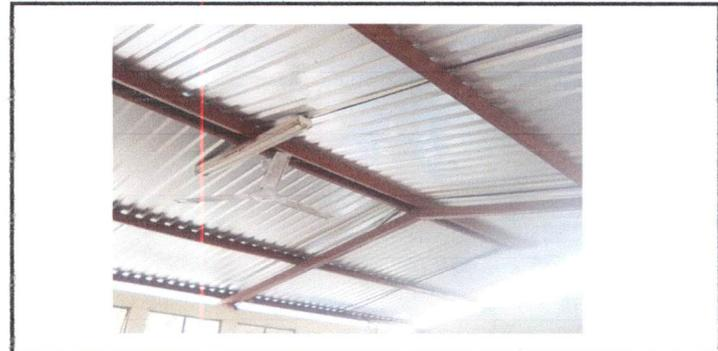
foto 4, mantenimiento a costaneras lijado y pintura en modulo 1
