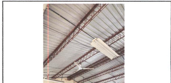
foto 2, mantenimiento a estructura Joist existente e instalacion de estructura de metal necesaria para la fijacion de lamina y sustitucion de elementos de fijacion en modulo 2
