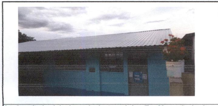
foto 5, sustitucion de lamina por lamina troquelada calibre 26 y sustitucion de capote en modulo 2
