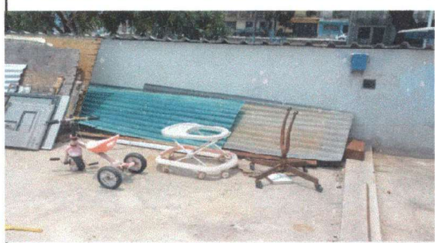
Foto 8: Impermeabilización de Losa
