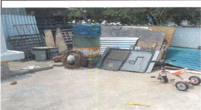
Foto 9: Impermeabilización de Losa
