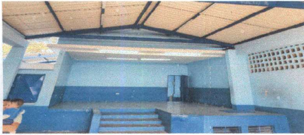
Foto1: Reparación de muros interiores
