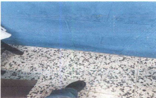
Foto 5: impermeabilización de muro
