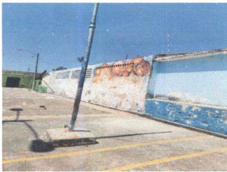
Foto 3: Pintura en muros exteriores e interiores
