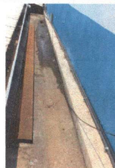
Foto 4: Reparación e impermeabilización de canal de cemento
