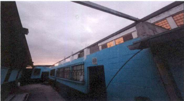
2,1 Levantado de Mojinetes 2 aulas de preprimaria,
