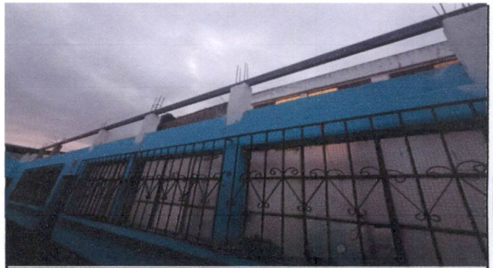
2,1 Levantado de Mojinetes 2 aulas de preprimaria,
