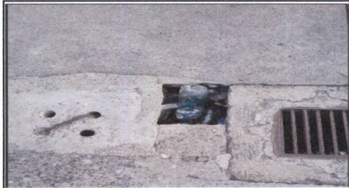
16,1 Fundicion en losa de patio.
