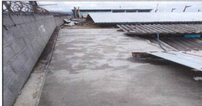
3,1 y 3,2 Aplicación de mezcilon e impermeabilizacion de direccion.
