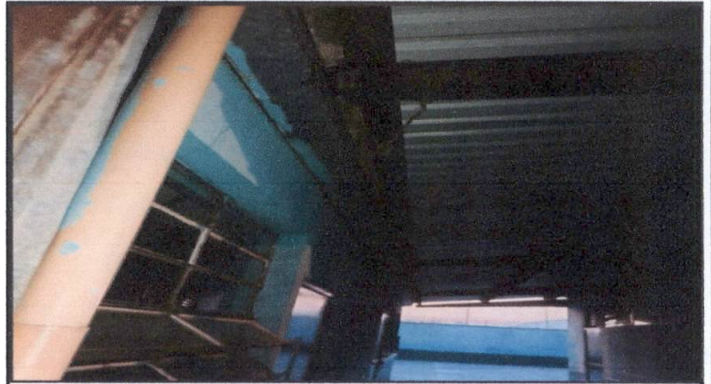
7,1 Cambio de canal y bajadas de agua,
