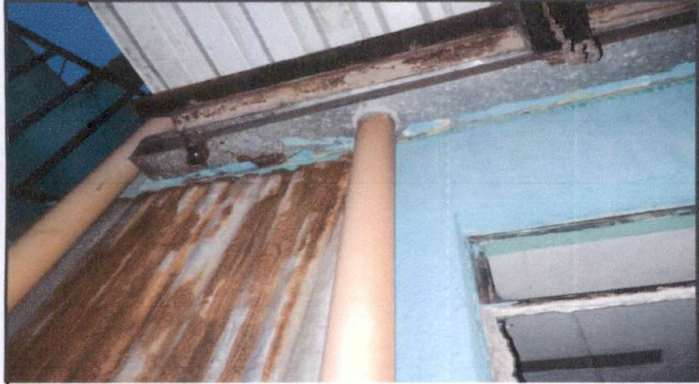
7,1 Cambio de canal y bajadas de agua,
