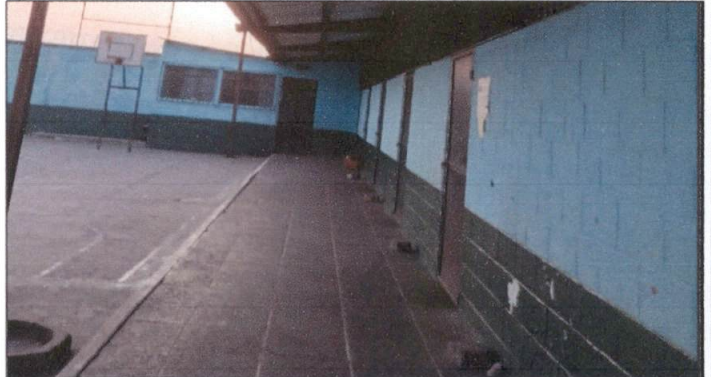
16,1 Fundicion en losa de patio.
