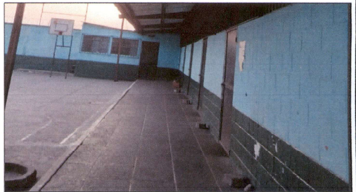
16,1 Fundicion en losa de patio.
