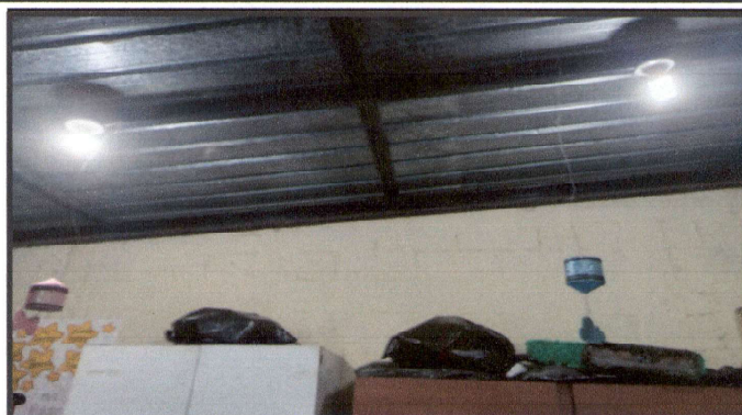
1,1 Cambio de techo con lamina troquelada 140 mts en 2 aulas y cocina.
