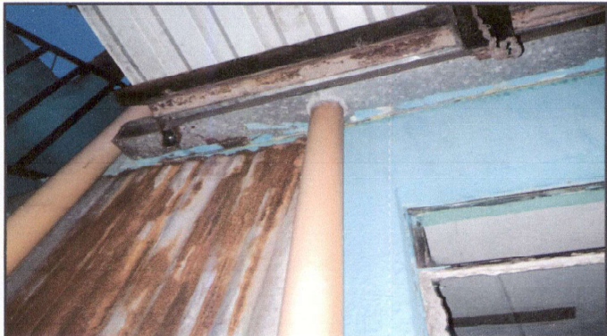
7,1 Cambio de canal y bajadas de agua,
