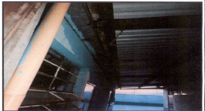
7,1 Cambio de canal y bajadas de agua,
