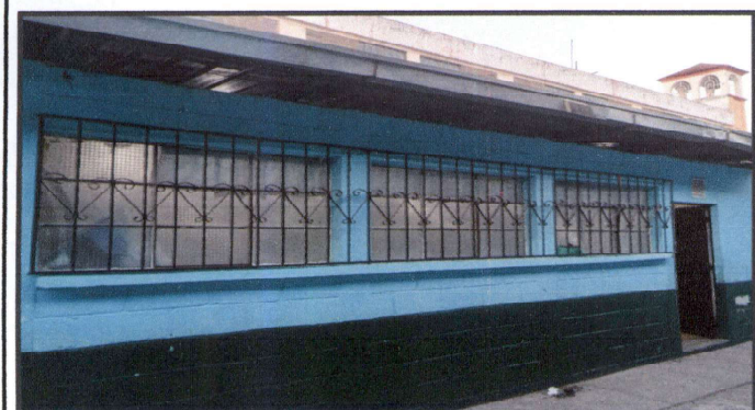
2,1 Levantado de Mojinetes 2 aulas de preprimaria,
