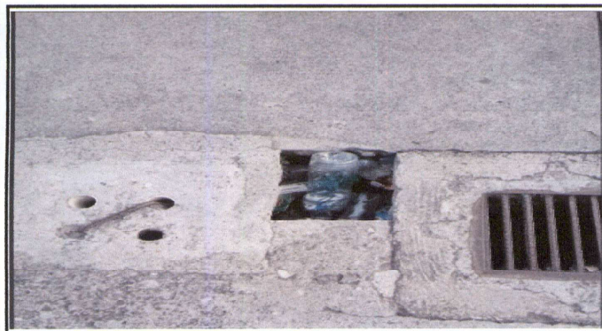
16,1 Fundicion en losa de patio.
