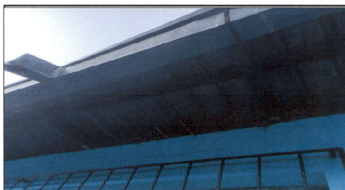
2,1 Levantado de Mojinetes 2 aulas de preprimaria,
