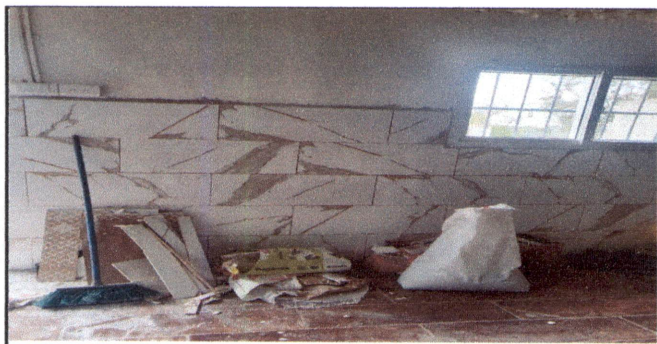
FOTO 15:REPARACION Y CERNIDO DE PAREDES DE COCINA
