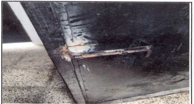
FOTO 46: MANTENIMIENTO A PUERTAS DE SANITARIOS
