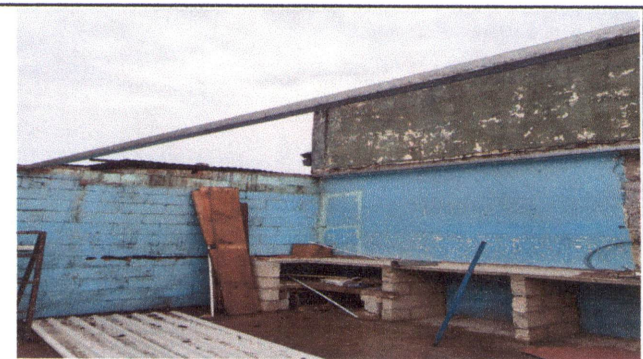
Foto 4: ESTRUCTURA DE METAL DE COCINA
