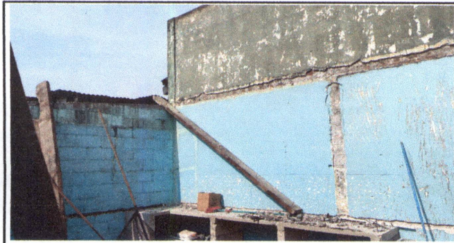
Foto 3: ESTRUCTURA DE METAL DE COCINA
