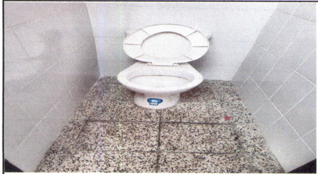
FOTO 31 : SUSTITUCION E INSTALACION DE SANITARIO Y LAVAMANOS (BAÑOS DE NIÑOS)
