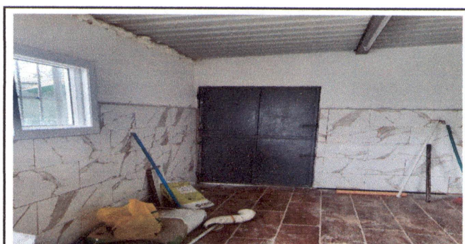
FOTO 16:REPARACION Y CERNIDO DE PAREDES DE COCINA
