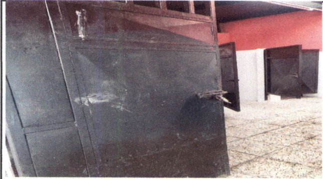
FOTO 43 : MANTENIMIENTO A PUERTAS DE SANITARIOS
