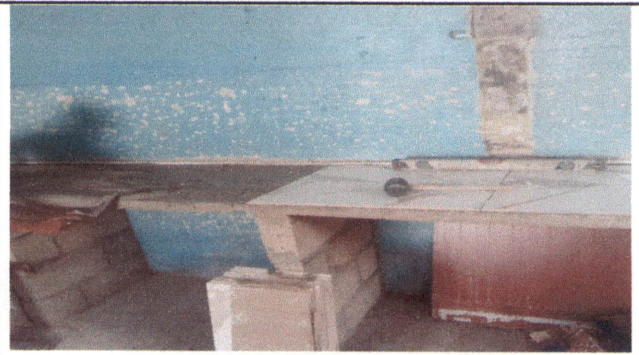
FOTO 38 :REPACION DE ENCINERA DE COCINA/PLANCHA DE CONCRETO
