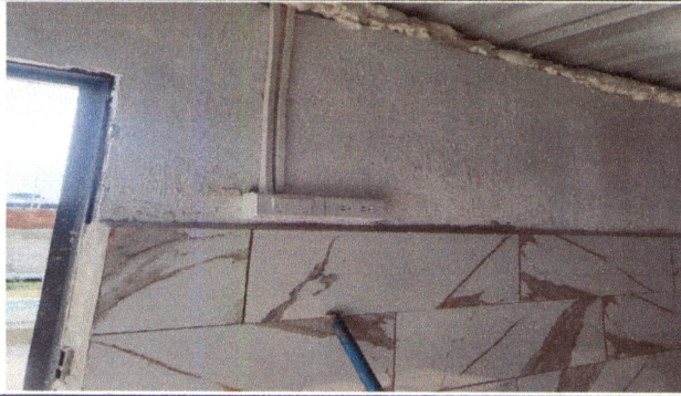
FOTO 19: TOMACORRIENTES/APAGADORES DE COCINA
