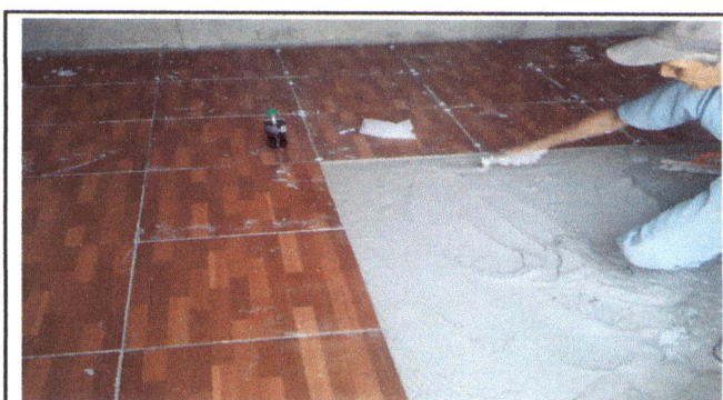
FOTO 10: COLOCACION DE PISO EN BODEGA
