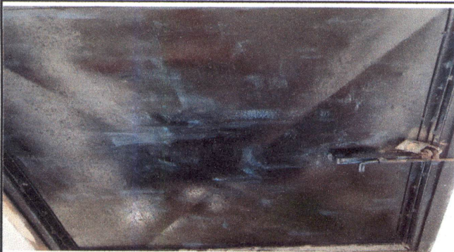
FOTO 45: MANTENIMIENTO A PUERTAS DE SANITARIOS
