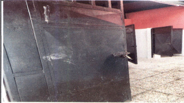
FOTO 43 : MANTENIMIENTO A PUERTAS DE SANITARIOS
