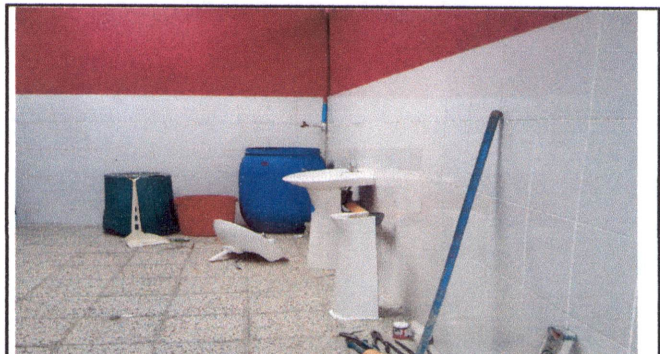
FOTO 34: SUSTITUCION E INSTALACION DE SANITARIO Y LAVAMANOS (BAÑOS DE NIÑOS)
