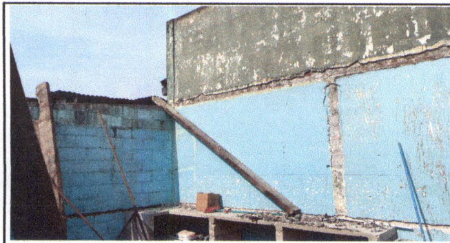
Foto 3: ESTRUCTURA DE METAL DE COCINA
