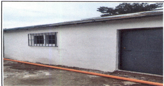
FOTO 11: CANALES PLUVIALES Y BAJADAS DE AGUA DE COCINA
