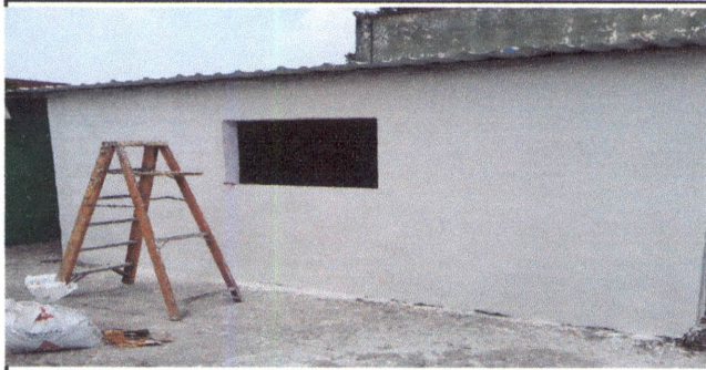
Foto1: SUSTITUCION DE TECHO DE LAMINA POR LAMINA TROQUELADA CALIBRE 26 ALUZINC
