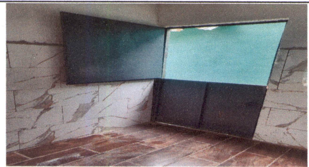
FOTO 41:SUSTITUCION DE PUERTAS DE METAL CON CHAPA , AREA DE COCINA
