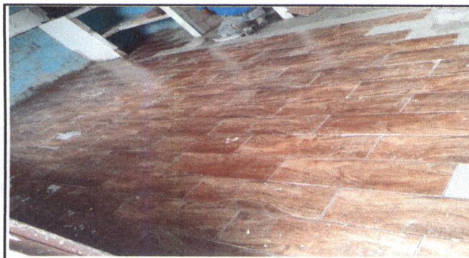
FOTO 9: COLOCACION DE PISO CERAMICO EN COCINA Y BODEGA
