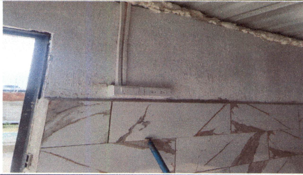
FOTO 19: TOMACORRIENTES/APAGADORES DE COCINA
