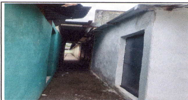
FOTO 12 : CANALES PLUVIALES Y BAJADAS DE AGUA DE COCINA
