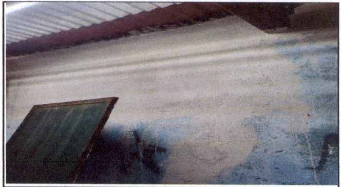
FOTO 50: REPELLO Y CERNIDO DE PARED DE BODEGA
