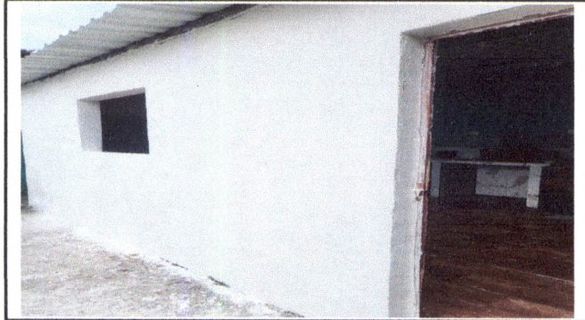
FOTO 7: SUSTITUCION Y AMPLEACION DE VENTANAS CON BALCON DE COCINA
