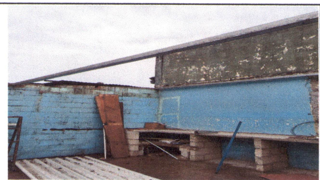
Foto 4: ESTRUCTURA DE METAL DE COCINA
