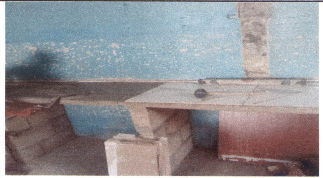
FOTO 38 :REPACION DE ENCINERA DE COCINA/PLANCHA DE CONCRETO
