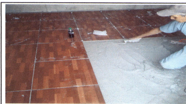
FOTO 10: COLOCACION DE PISO EN BODEGA
