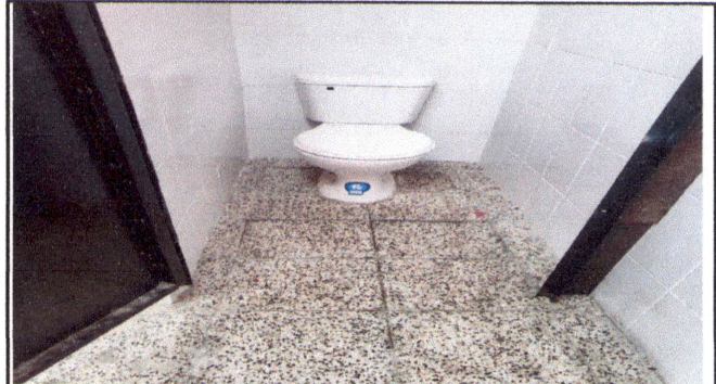
FOTO 32 : SUSTITUCION E INSTALACION DE SANITARIO Y LAVAMANOS (BAÑOS DE NIÑOS)
