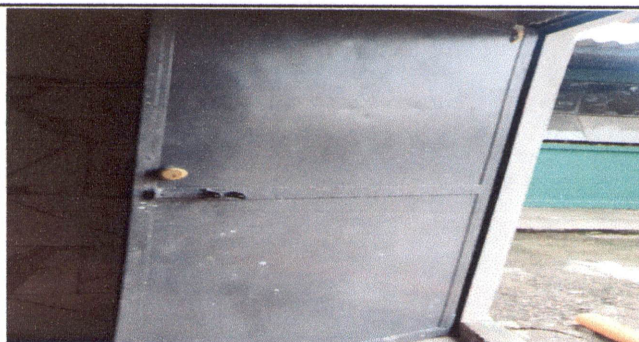
FOTO 42:SUSTITUCION DE PUERTAS DE METAL CON CHAPA , AREA DE COCINA
