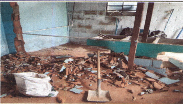
FOTO 39: DEMOLICION DE PARED DE COCINA ( INCLUYE SACADO DE RIPIO)
