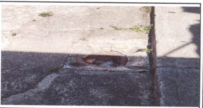
FOTO 30: SUSTITUCION Y MANTENIMIENTO DE REPOSADERAS Y DRENAJES DE COCINA Y PATIO
