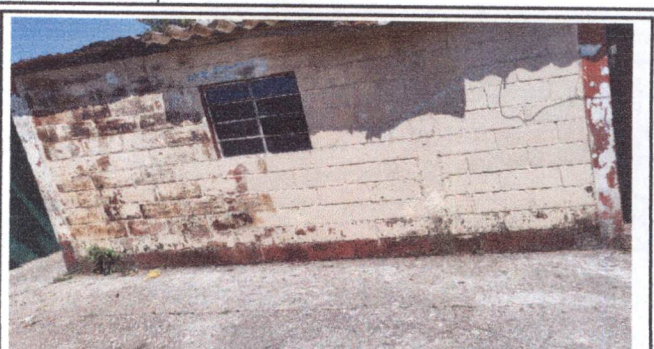
FOTO 26 : PINTURA INTERIOR Y EXTERIOR, COCINA Y BODEGA
