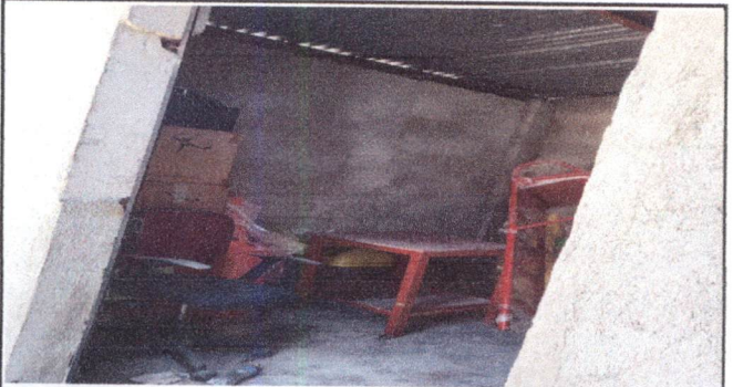
FOTO 27: PINTURA INTERIOR Y EXTERIOR, COCINA Y BODEGA
