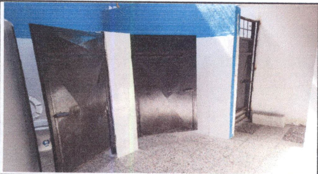
FOTO 45: MANTENIMIENTO A PUERTAS DE SANITARIOS
