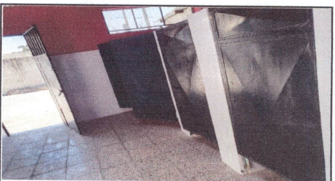
FOTO 46: MANTENIMIENTO A PUERTAS DE SANITARIOS
