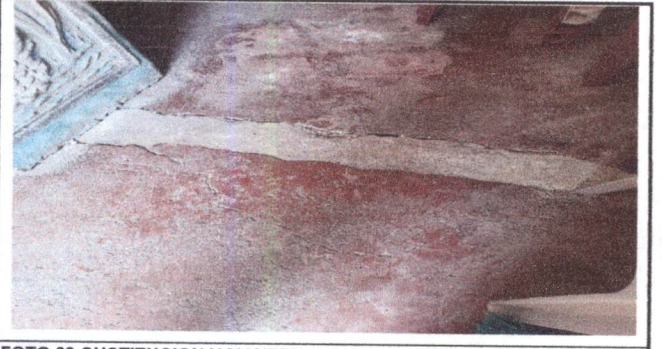
FOTO 20: SUSTITUCION Y MANTENIMIENTO DE REPOSADERAS Y DRENAJES DE COCINA Y PATIO
