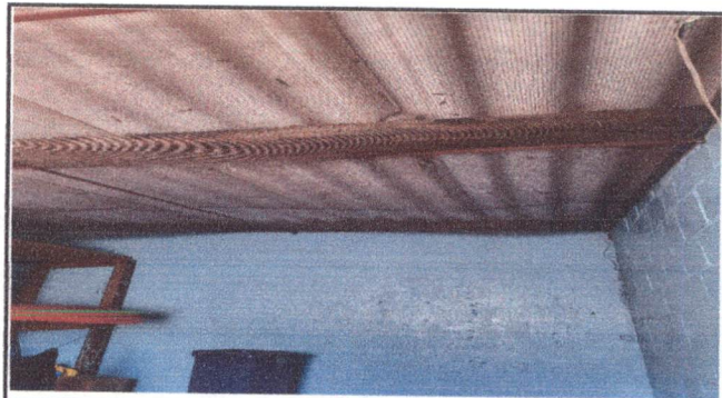
Foto 4: ESTRUCTURA DE METAL DE COCINA
