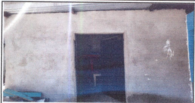
FOTO 25 : PINTURA INTERIOR Y EXTERIOR, COCINA Y BODEGA
