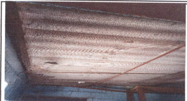
Foto 2: SUSTITUCION DE TECHO DE LAMINA POR LAMINA TROQUELADA CALIBRE 26 ALUZINC
