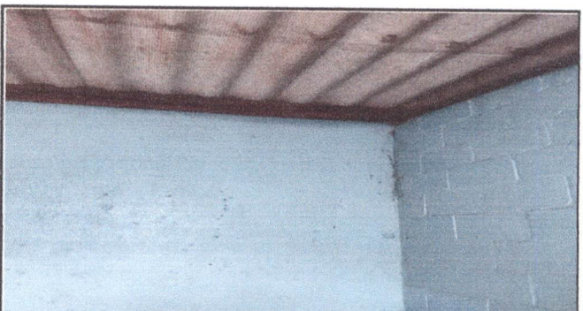
FOTO 16:REPARACION Y CERNIDO DE PAREDES DE COCINA
