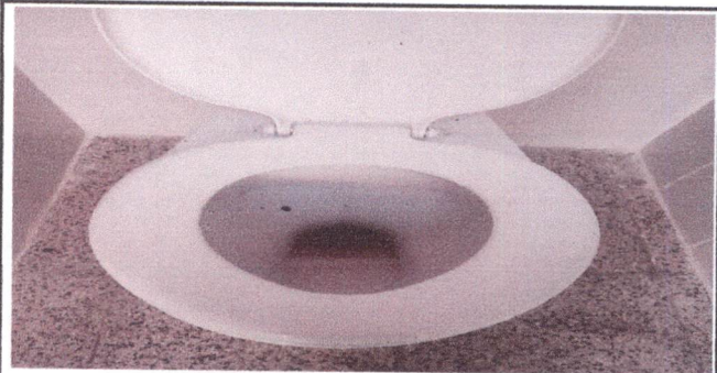
FOTO 34: SUSTITUCION E INSTALACION DE SANITARIO Y LAVAMANOS (BAÑOS DE NIÑOS)
