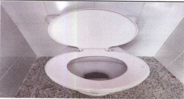
FOTO 33: SUSTITUCION E INSTALACION DE SANITARIO Y LAVAMANOS (BAÑOS DE NIÑOS)
