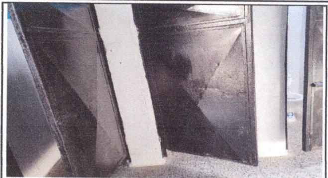
FOTO 44: MANTENIMIENTO A PUERTAS DE SANITARIOS
