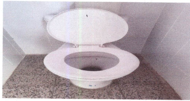
FOTO 31 : SUSTITUCION E INSTALACION DE SANITARIO Y LAVAMANOS (BAÑOS DE NIÑOS)
