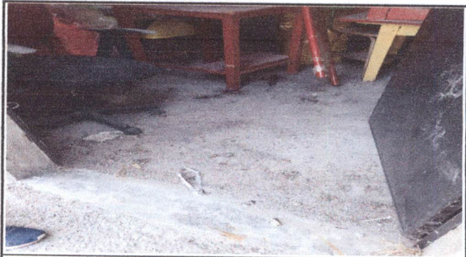
FOTO 10: COLOCACION DE PISO EN BODEGA
