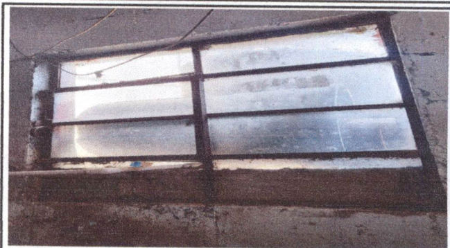
FOTO 8: SUSTITUCION Y AMPLEACION DE VENTANAS CON BALCON DE COCINA
