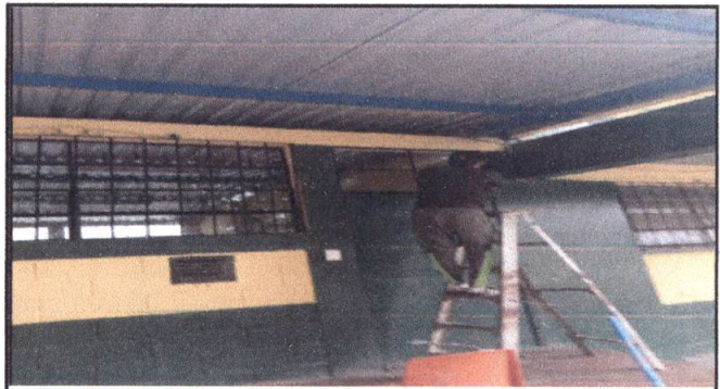
FOTO 4 COLOCACIÓN DE VIDRIOS
