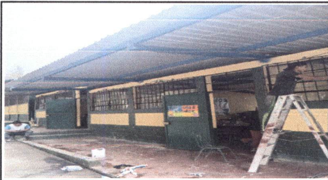
FOTO 3 COLOCACIÓN DE VIDRIOS
