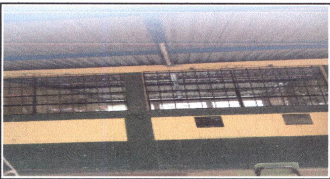
FOTO 5 COLOCACIÓN TOTAL DE VIDRIOS
