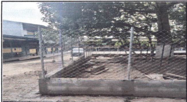
FOTO 3 REPARACIÓN DEL MURO DE LA PARTE DE ATRÁS Y CIERRE DEL ÁREA DEL PARQUE
