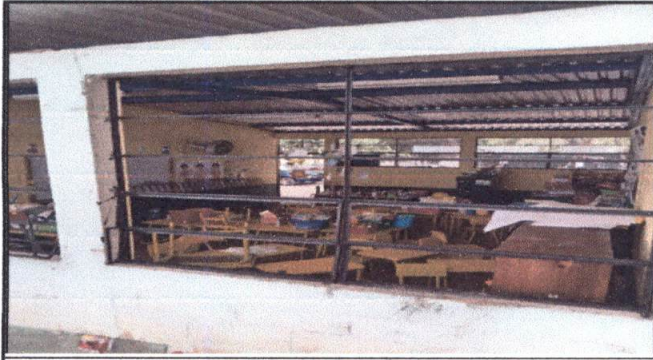
FOTO 1 SE RETIRAN VIDRIOS DE VENTANAS
