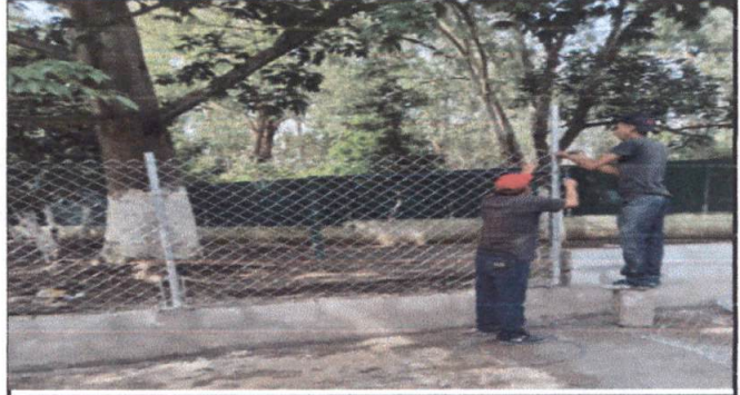
FOTO 2 COLOCACIÓN DE MAYA SOBRE EL MURO DEL ÁREA DE JUEGOS
