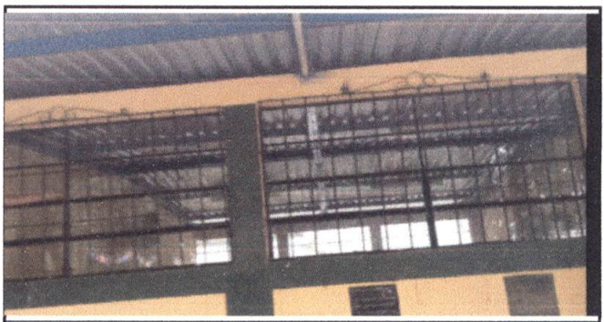
FOTO 6 COLOCACIÓN TOTAL DE VIDRIOS
