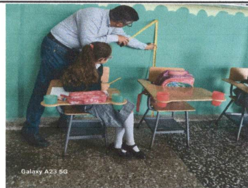
Foto 4: La grada abarca la mitad de la clase, que ya es pequeña, lo cual provoca que los alumnos en algunos casos se caigan. Se observa que existen 2 tipos de piso.
