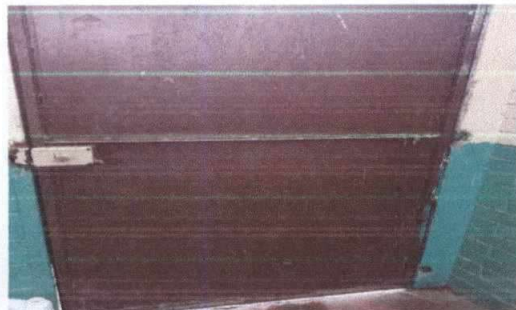
Foto 1: 4. Puertas de metal. 4.3 Instalación de Puertas
