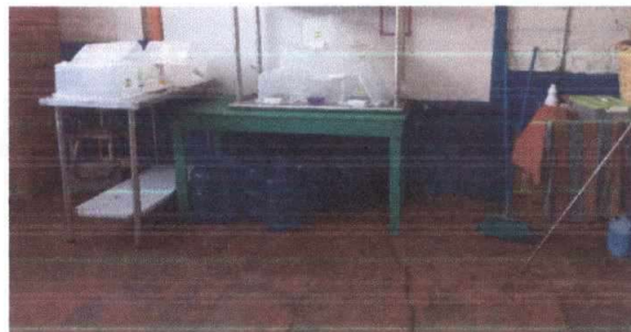
Foto 2: 6. Piso 6.7 Sustitución de piso de granito
