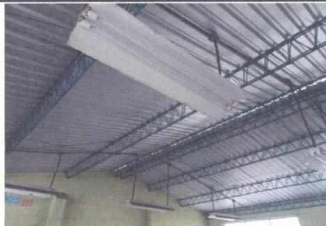
FOTO 2: SUSTITUCIÓN DE LÁMINA DE DURALITA POR LÁMINA TROQUELADA CALIBRE 26 EN AULAS DE SEGUNDO NIVEL
