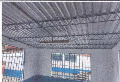
FOTO 1: SUSTITUCIÓN DE LÁMINA DE DURALITA POR LÁMINA TROQUELADA CALIBRE 26 EN ÁREA DE GRADAS
