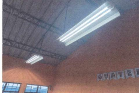
FOTO 8: SUSTITUCIÓN DE TUBOS LED DE LÁMPARAS
