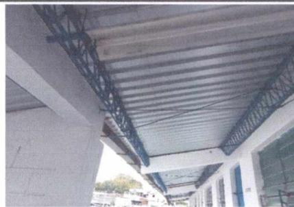
FOTO 4: SUSTITUCIÓN DE LÁMINA DE DURALITA POR LÁMINA TROQUELADA CALIBRE 26 EN ÁREA DE CORREDOR DE SEGUNDO NIVEL
