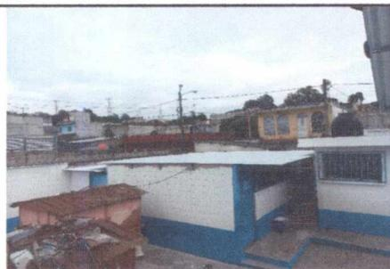
FOTO 5: SUSTITUCIÓN DE LÁMINA DE DURALITA POR LÁMINA TROQUELADA CALIBRE 26 EN AULA
