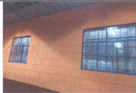
FOTO 12: SUSTITUCIÓN DE VENTANAS DE METAL CORREDIZAS
