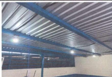
FOTO 3: SUSTITUCIÓN DE LÁMINA DE DURALITA POR LÁMINA TROQUELADA CALIBRE 26 EN AULA, SUSTITUCIÓN DE ESTRUCTURA DE SOPORTE DE METAL E INSTALACIÓN DE LÁMPARAS
