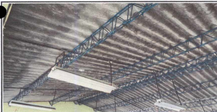
Foto 5: Techo de duralita de aula de segundo nivel. (5o. B)
