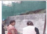
FOTO 17: REPARACIÓN DE MURO DE CONTENCIÓN (PINTURA, REPELLO DE GRIETAS Y AGUJEROS)
