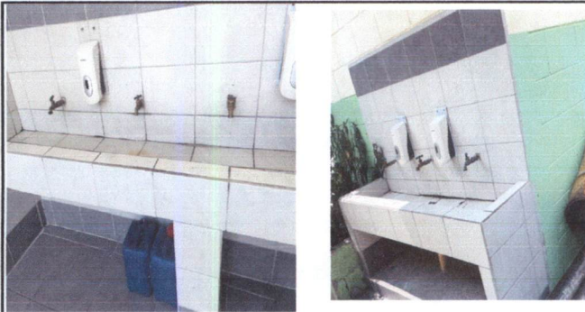
Foto17: CONSTRUCCION DE LAVAMANOS
