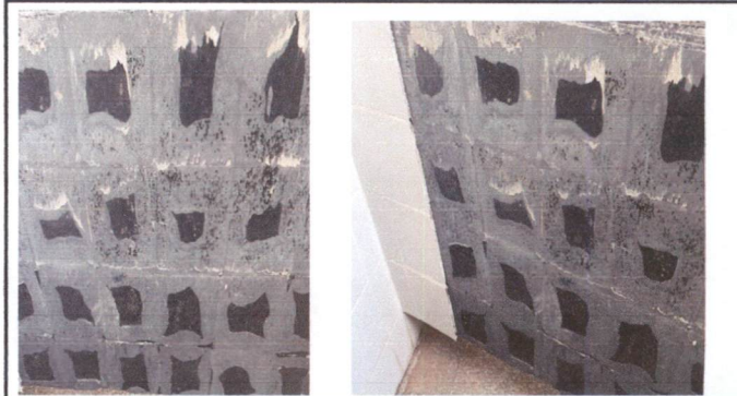
Foto 16: REPARACION DE AZULEJOS
