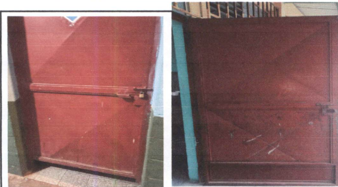
Foto 15: MANTENIMIENTO DE PUERTAS DE AULAS
