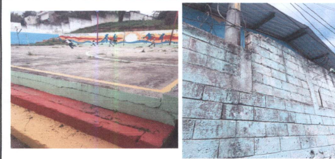
Foto 13; PINTURA EN MUROS EXTERIORES E INTERIORES
