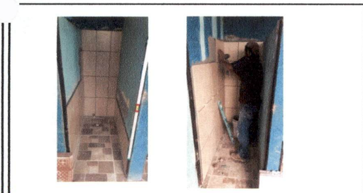
Foto 11: Suministro de azulejo en paredes de baños
