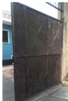
Foto 2: Mantenimiento porton de metal
