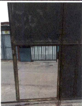
Foto 3: Mantenimiento porton de metal
