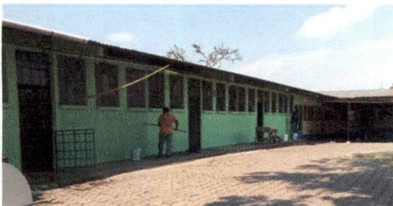
Foto 5: Pintura en muros exteriores e interiores
