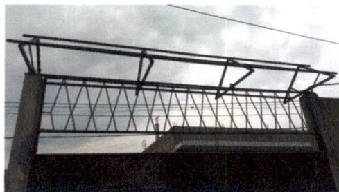
Foto 4: Mantenimiento de porton de metal y techo para proteccion
