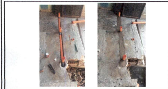
Foto 9: Suministro de reposadera y drenajes en baños
