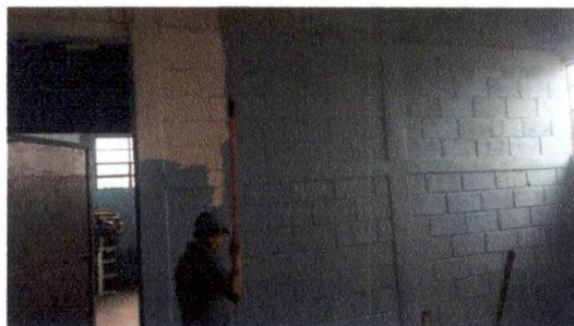
Foto 6: Pintura en muros exteriores e interiores
