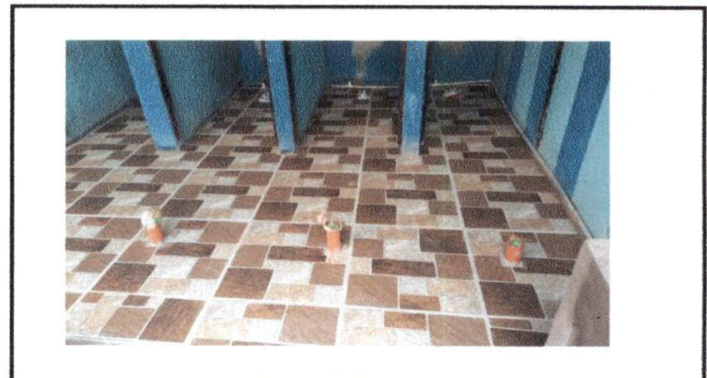
Foto 8: Reparación de piso de torta de concreto baño
