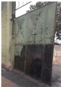
Foto 1: Mantenimiento porton de metal
