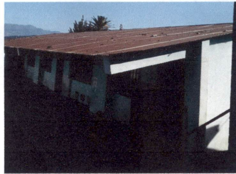
Foto 4: 9. PINTURA EN MUROS
