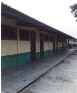
Foto 5: 9. PINTURA EN MUROS
