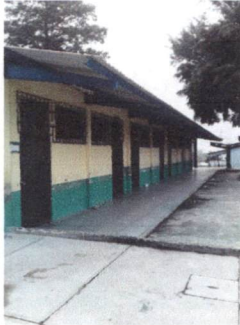
Foto 7: 9. PINTURA EN MUROS
