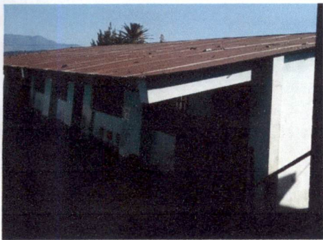
Foto 3: 9. PINTURA EN MUROS
