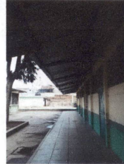
Foto 8: 9. PINTURA EN MUROS
