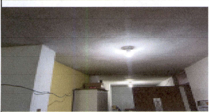
impermeabilización de losa area de direccion e instalacion de lamparas led de tubo
