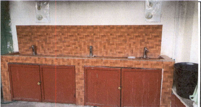
sustitucion de grifos de lavamanos
