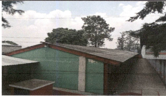
Foto 1: Vista panorámica del Módulo 1. Grados que ocupa: Primero Básico, Secciones A, B, C, D y E ; Segundo Básico, Sección "A". Más de 40 años con techo de Duralita.
