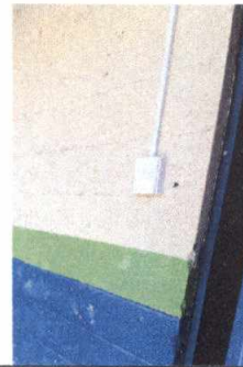
Foto 14: Reparación de interruptores en sanitarios
