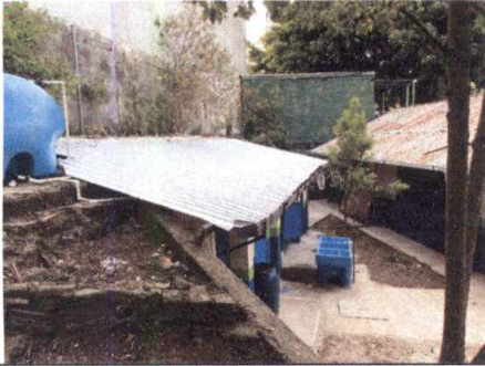
Foto 1: Sustrucción de lámina en sanitario de docentes, alumnos y alumnas.
