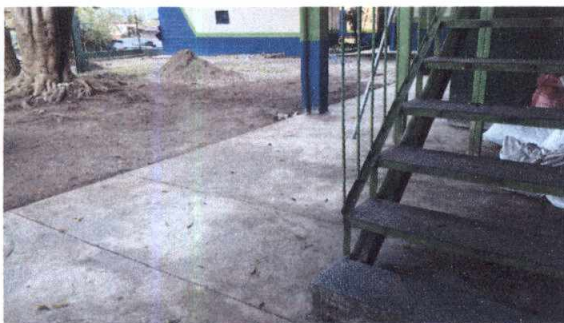
Foto 11: Fabricación de losa de patio
