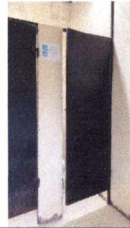
Foto 4: Reparación e instalación de puertas a sanitarios de alumnos y alumnas.
