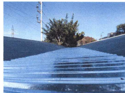
Foto 18: Instalación de lámina en losa para evitar acumulación de agua.
