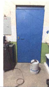
Foto 16: Fabricación e instalación de puerta en área de bodega de dirección.
