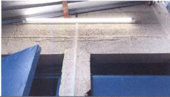
Foto 13: Reparación de sistema eléctrico y luz LED
