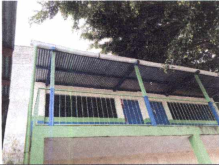
Foto 7: Sustrucción de canales y bajas de agua
