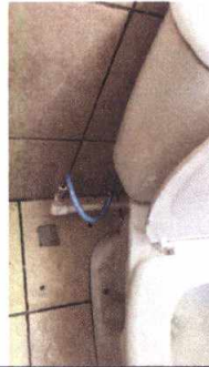
Foto 9: Reparación de accesorios en sanitarios
