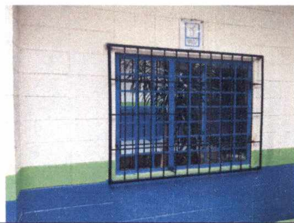
Foto 6: Instalación de balcones en área administrativa y laboratorio de computación
