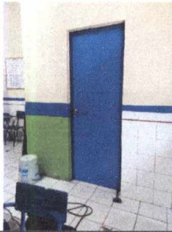
Foto 15 Fabricación e instalación de puertas en 4to. PC
