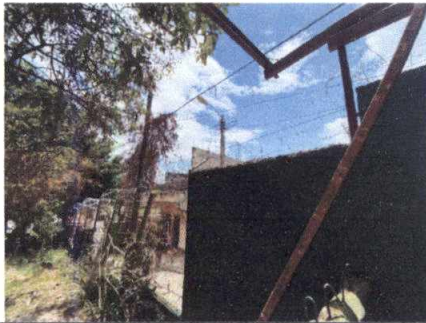
Foto 9: Sustrucción de alambre de pua razor
