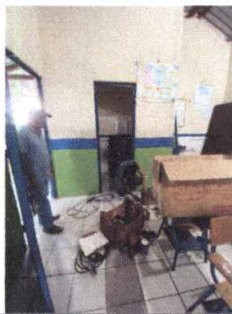
Foto 11: Fabricación e instalación de puertas en 4to. PC
