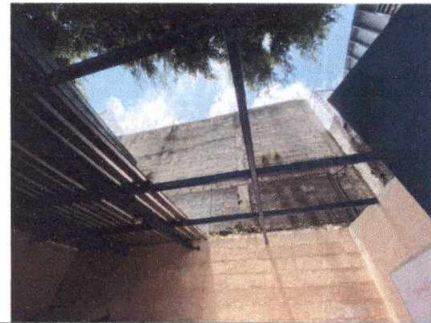
Foto 10: Sustrucción de lámina en area de bodega
