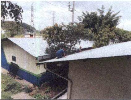
Foto 1: Sustrucción de canal de PVC en salones de 4to. Y 5to. PC
