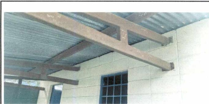
Foto 3: Sustitución de lámina y levantamiento de dos hiladas por exceso de calor.
