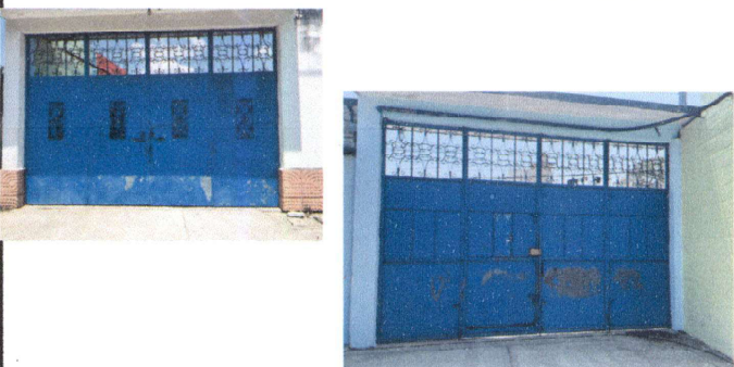
Foto 5: Mantenimiento a portones de metal de la entrada principal de la escuela (lijado y aplicación de pintura).
