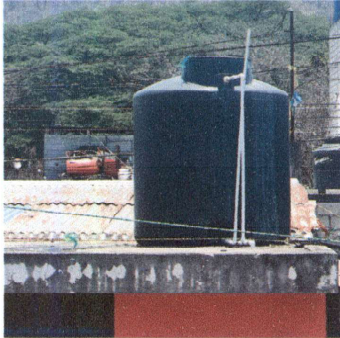
Foto 7: Sustitución de deposito de agua 1700 lt.
