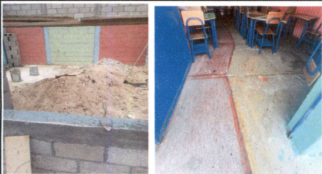
Foto 3: sustrucción de piso de torta de concreto por piso de granito en el área de cocina, clase de párvulos 3 "C" y bodega.
