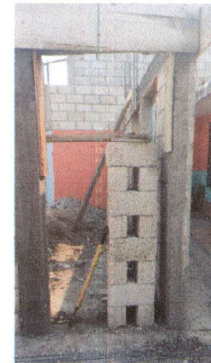
Foto 10: Fabricación e instalación de puerta de metal en el área de cocina.
