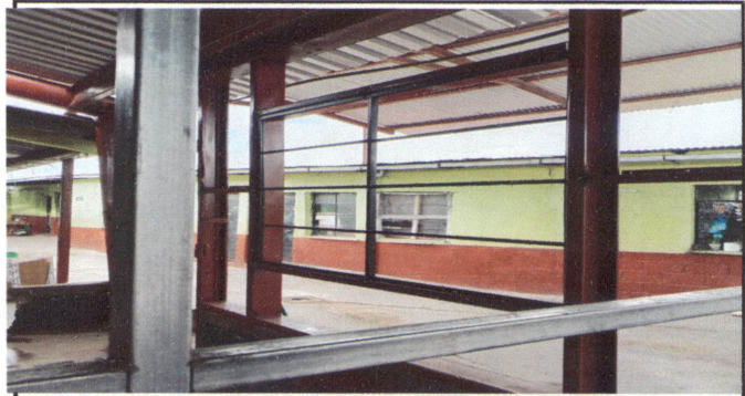
Foto 8: Sustitución de estructura de soporte de madera por metal, desmontaje de madera por metal e instalación de costaneras.
