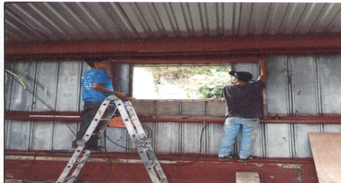
Foto 3: Desmantelar aula de madera y metal.
